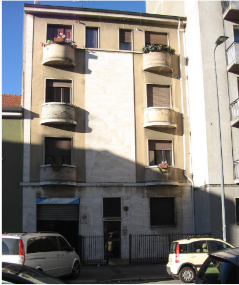
Vista esterna dell'edificio
