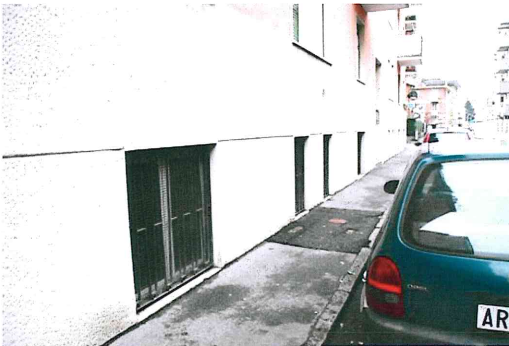
FOTO 8,9 – vista esterna di via degli Artigiani. Vista delle finestre dell'immobile pignorato su strada.
