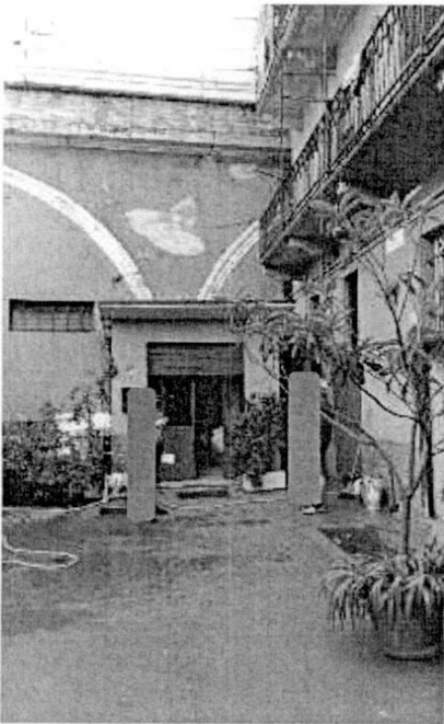
Vista cortile zona portineria
