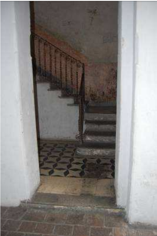
Scala comune di accesso all'unità immobiliare
