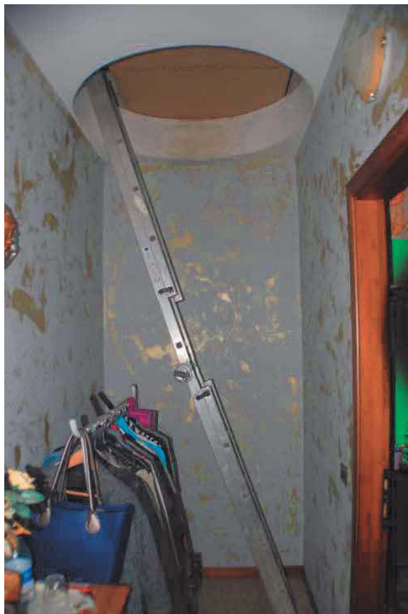
Botola di accesso al sottotetto
