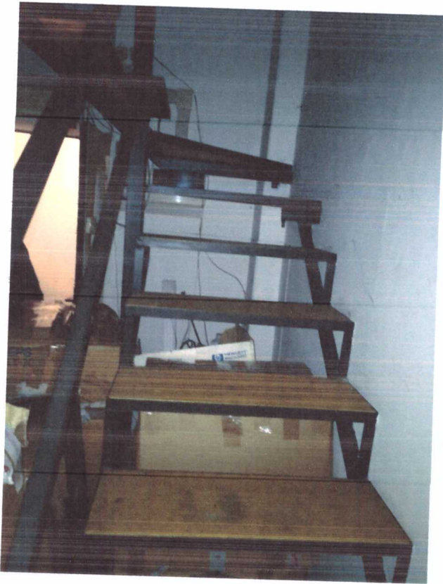
Vista scala interna per soppalco
