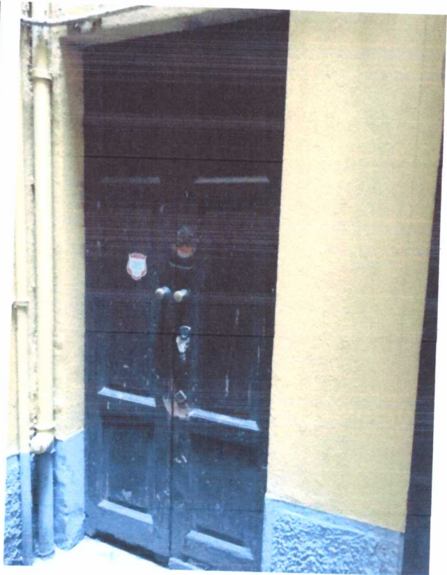
Vista porta ingresso dal cortile unità Sub. 702
