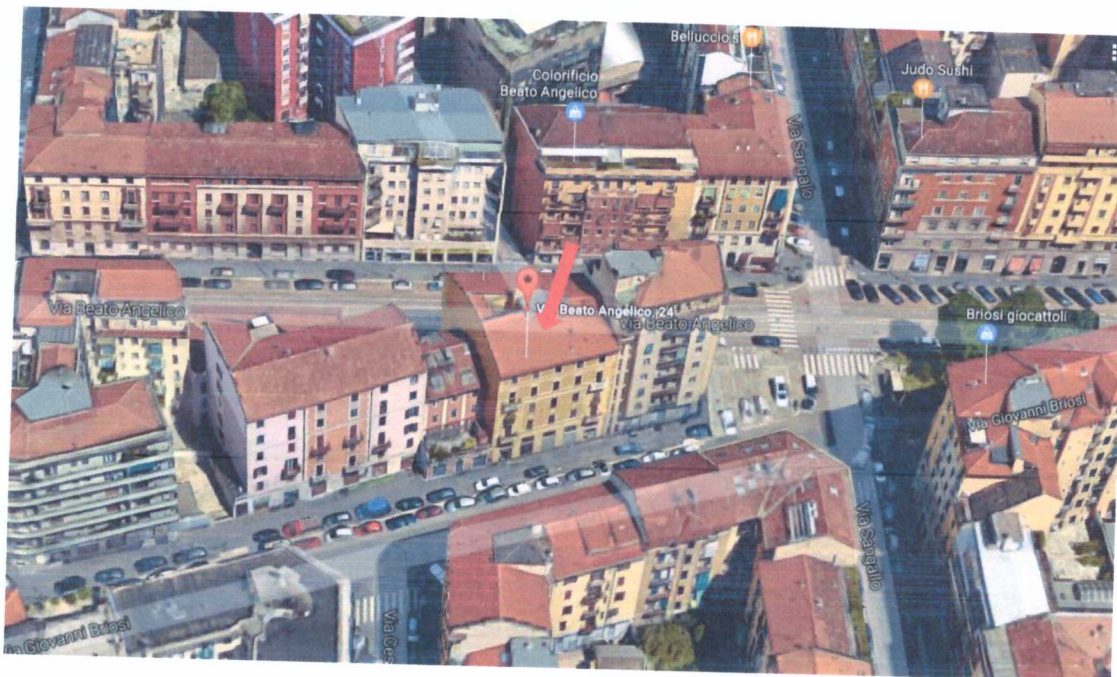
Vista assonometrica del fabbricato da Google Maps
