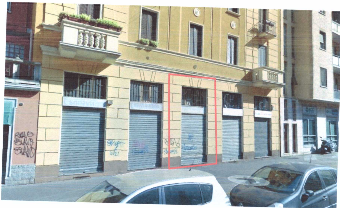
Vista del fabbricato da Via Briosi e vetrina di pertinenza
