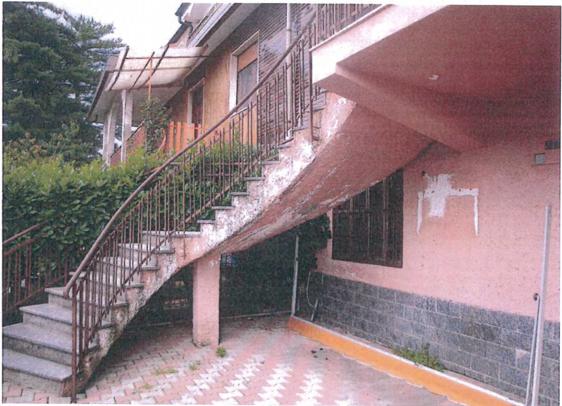
R.G.E. 2071/2013, G.E. Dott.ssa Mennuni Trezzano sul Naviglio, Via Brunelleschi 27 angolo Via Patti 2, Foglio 6, mapp. 577, sub 3 – Prospetti esterni dalla Via Patti e la scala di ingresso.
