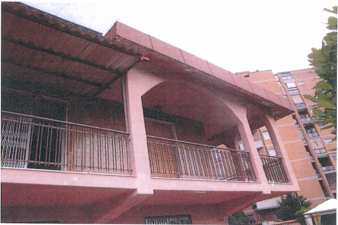
R.G.E. 2071/2013, G.E. Dott.ssa Mennuni Trezzano sul Naviglio, Via Brunelleschi 27 angolo Via Patti 2, Foglio 6, mapp. 577, sub 3 – Prospetti esterni dalla Via Brunelleschi e dal cortile
