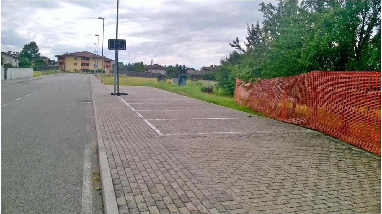
Foto n. 3 - Comune di Casarsa Della Delizia (PN), Foglio 6 – veduta della viabilità interna e dei parcheggi.
