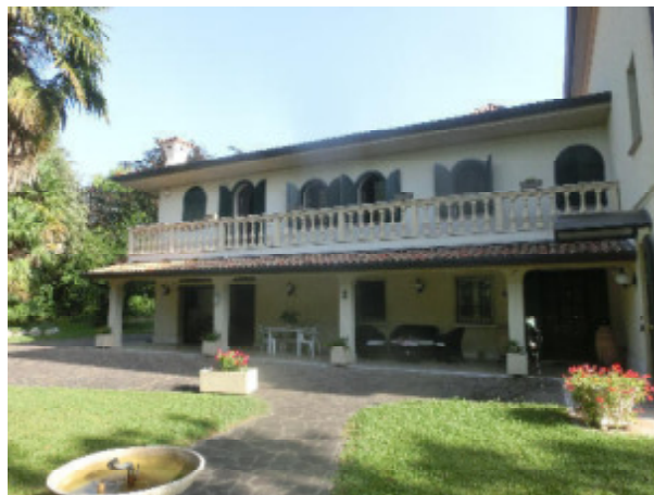
particolare prospetto Sud del fabbricato
