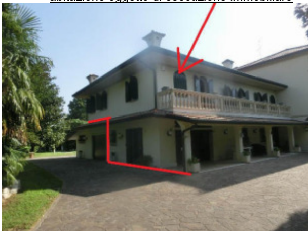
Prospetto Sud-Ovest del fabbricato
