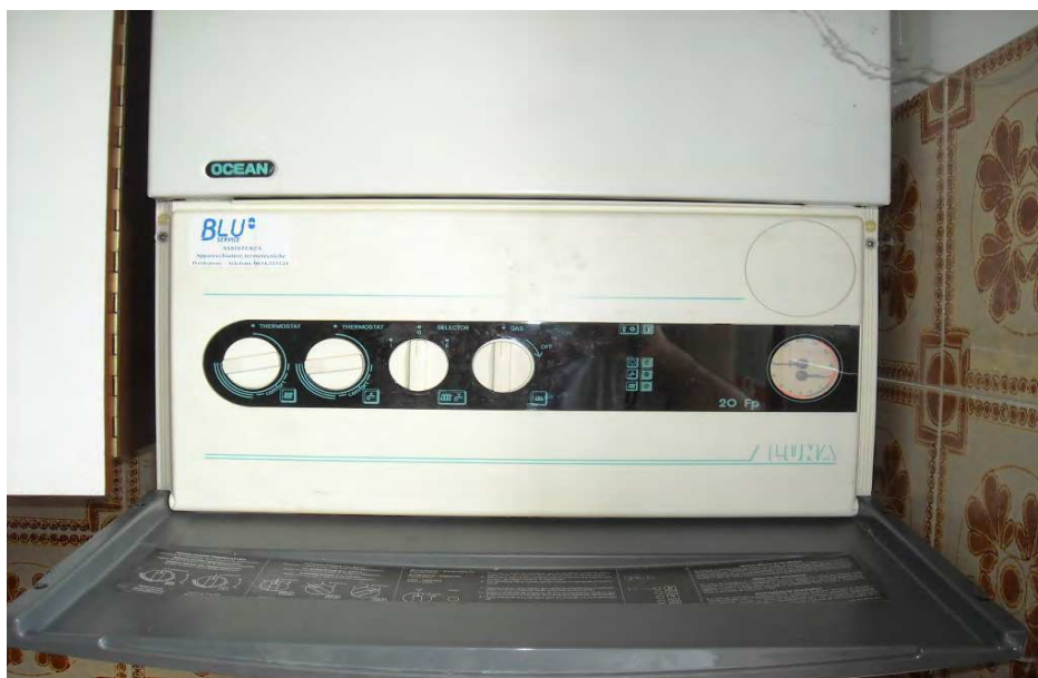
Foto 15 – caldaia autonoma
