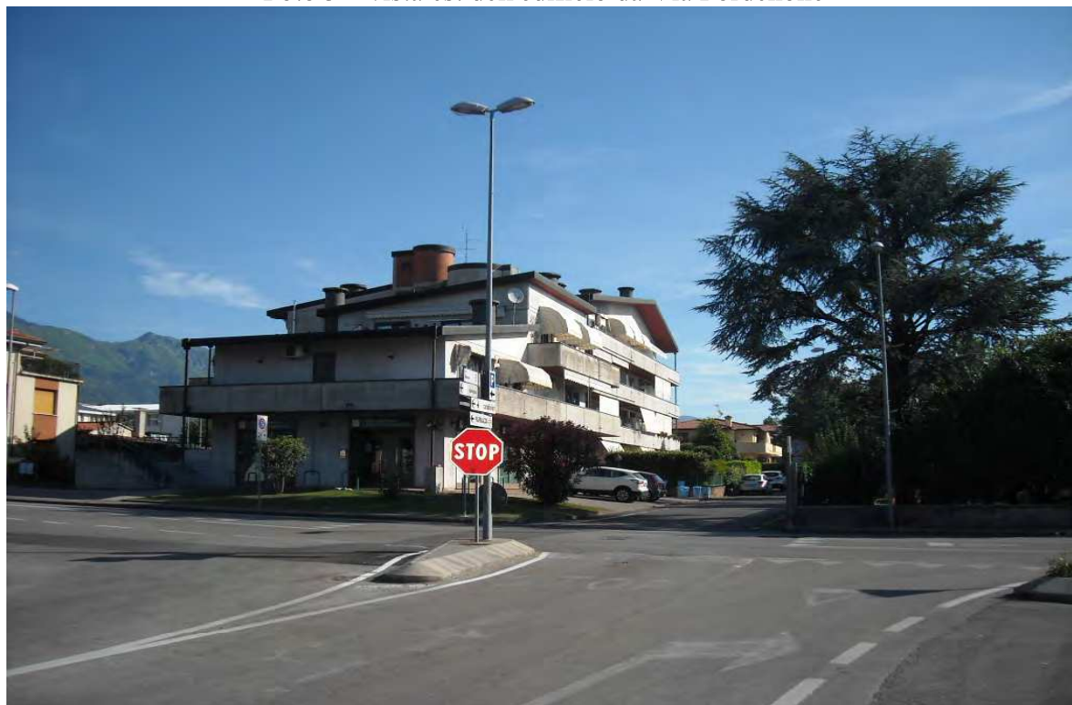
Foto 3 – vista est dell'edificio da Via Pordenone
