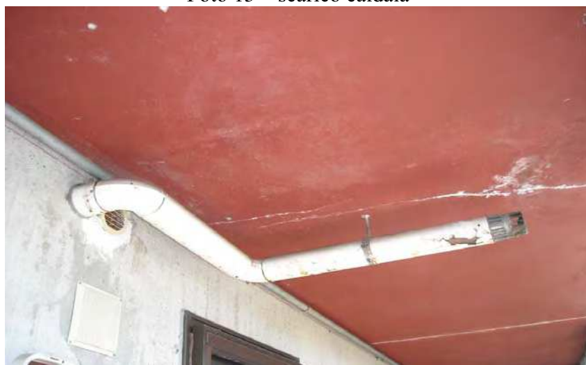
Foto 13 – scarico caldaia
