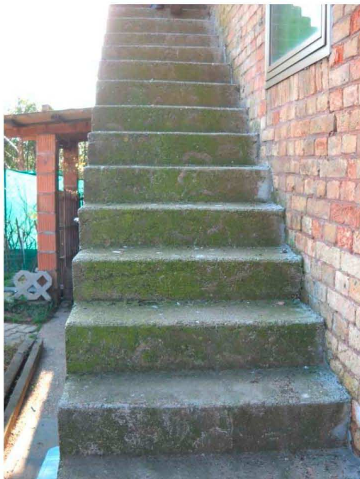
Foto 22 Scala esterna d'accesso al corpo accessorio ex fienile
