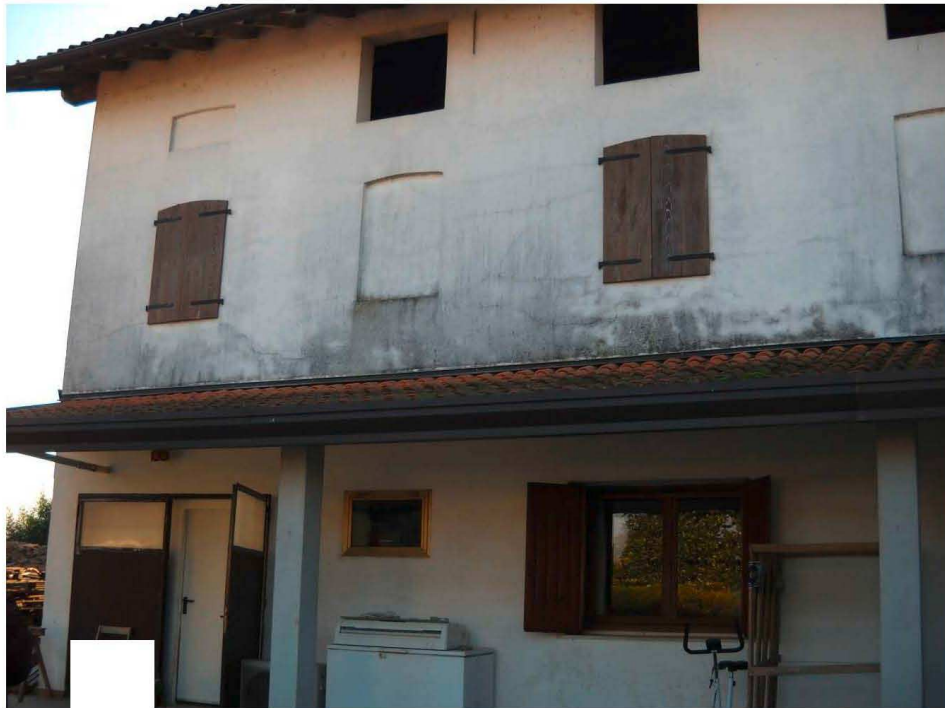
Foto 24 Ingresso Garage sub 2
