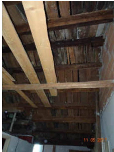
ulteriore particolare copertura
