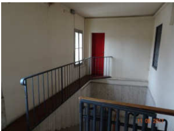
particolare porta d'ingresso al sub. 13
