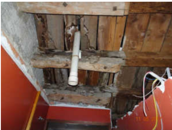
ulteriore particolare copertura
