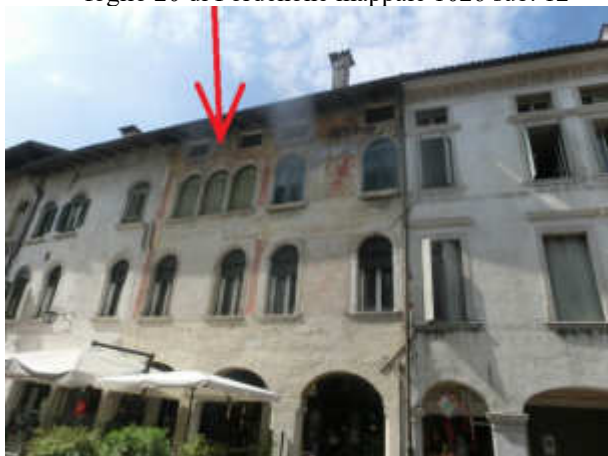
ulteriore particolare prospetto da Corso Vittorio Emanuele II
