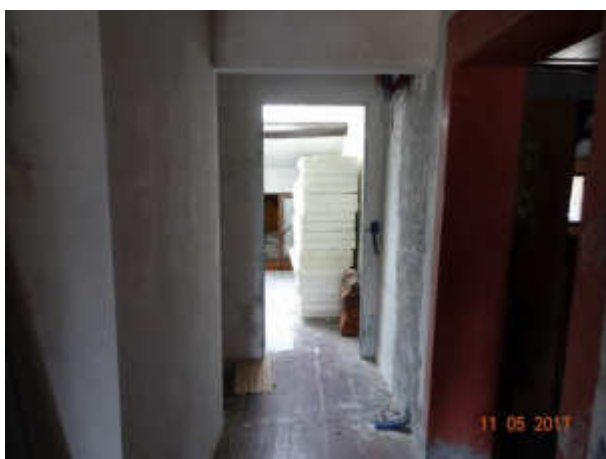
particolare zona ingresso
