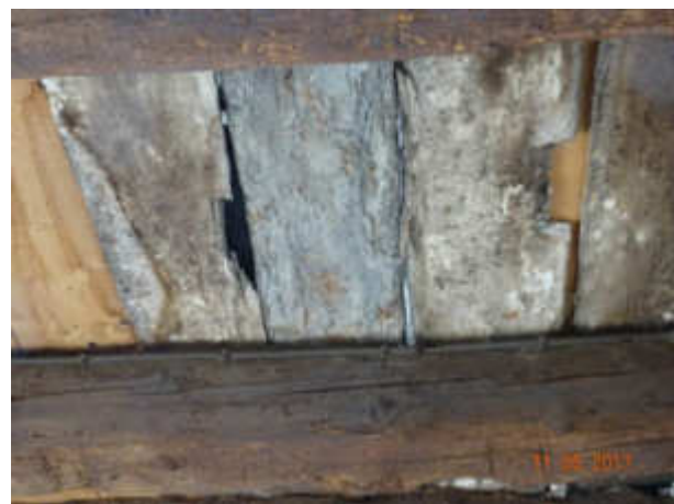
ulteriore particolare copertura
