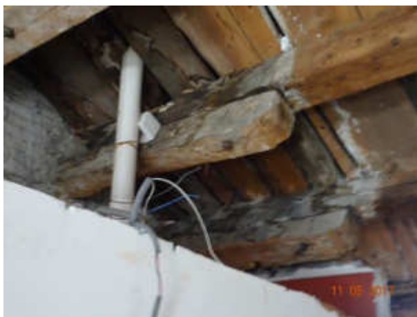
ulteriore particolare copertura
