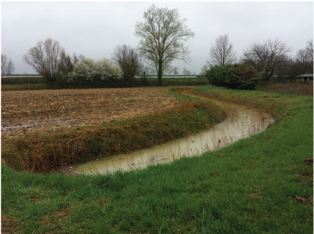
particolare canale verso nord
