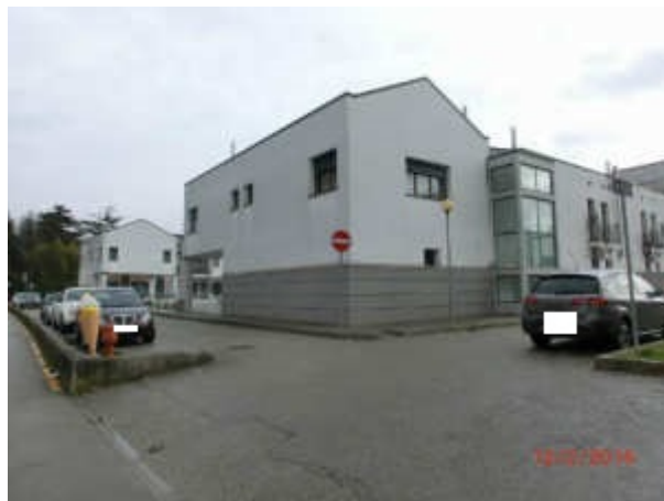
particolare prospetto Nord/Ovest del fabbricato -prospetti laterali-
