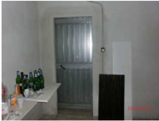
particolari vista interna del locale magazzino
