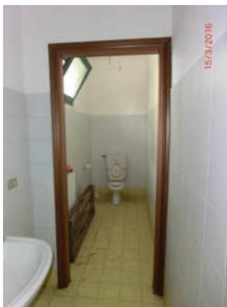
particolare vista interna dell'antibagno e bagno
