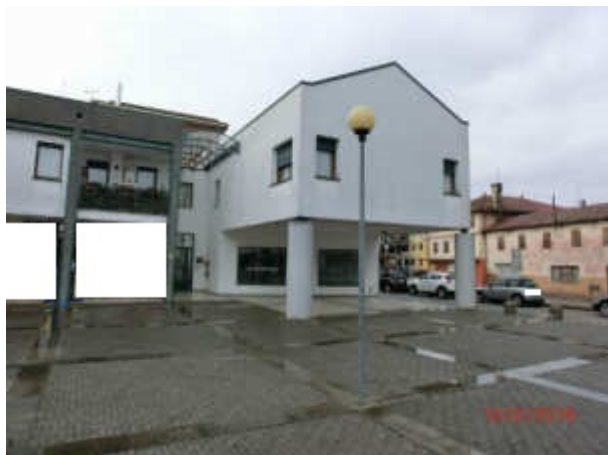
particolare prospetto Est del fabbricato -prospetto principale-
