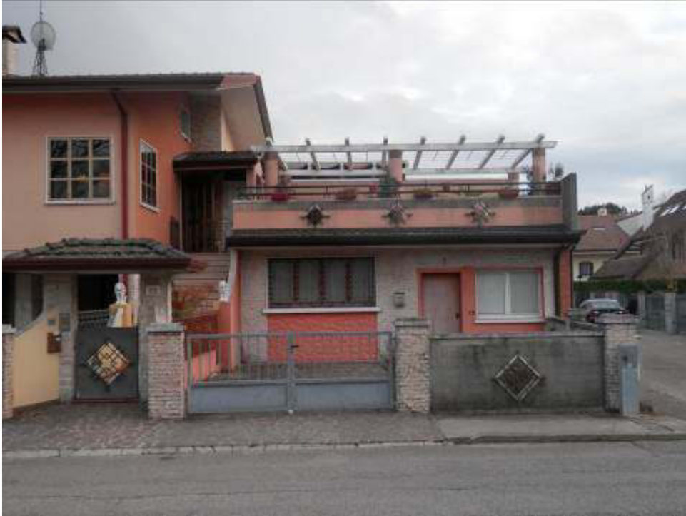
Foto 1-2: Fabbricato di abitazione lato Nord e lato Ovest.
