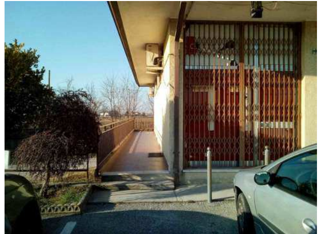
Particolare camminamento di accesso
