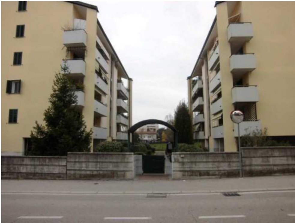
FOTO 1: INGRESSO PEDONALE DEL CONDOMINIO CORPO A e B
