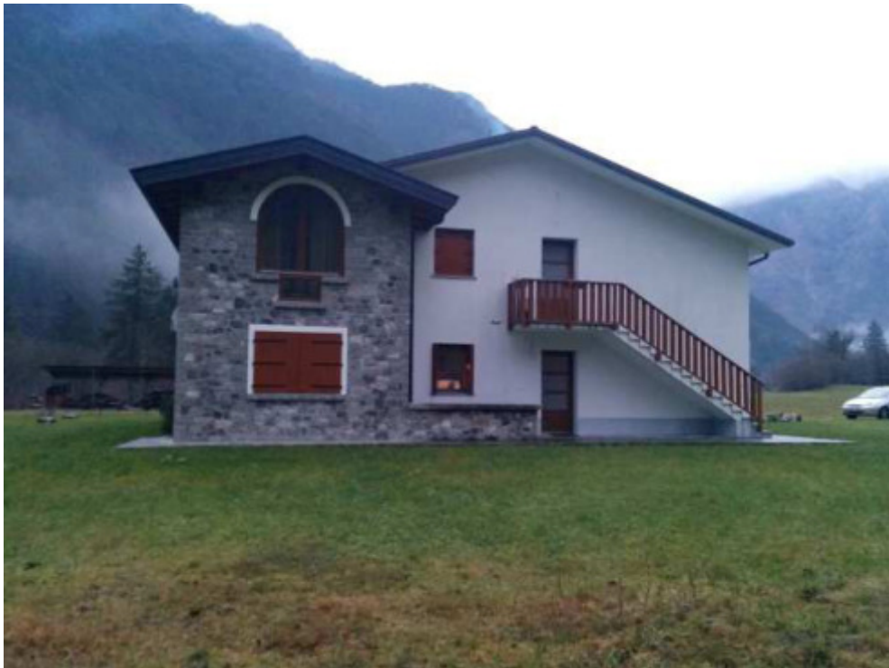
FOTO 26: PANORAMICA LATERALE E SCALE ACCESSO SUB. 2
