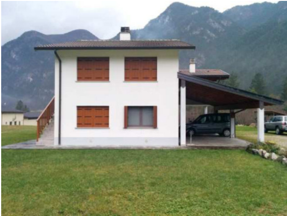
FOTO 25: PANORAMICA FRONTALE ABITAZIONE INTERA (Sub. 2 e 1)
