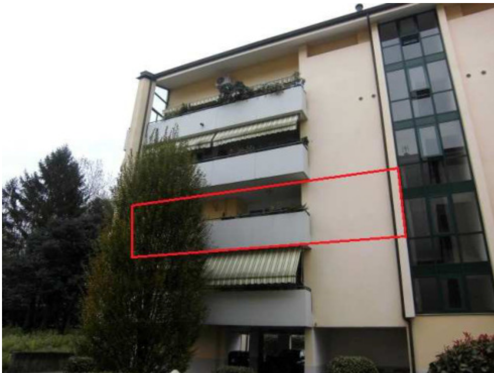
FOTO 4: APPARTAMENTO IN ESECUZIONE AL SECONDO PIANO
