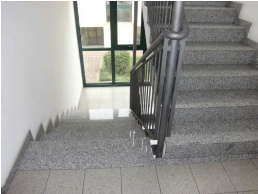
FOTO 6: VANO SCALE CONDOMINIALE
