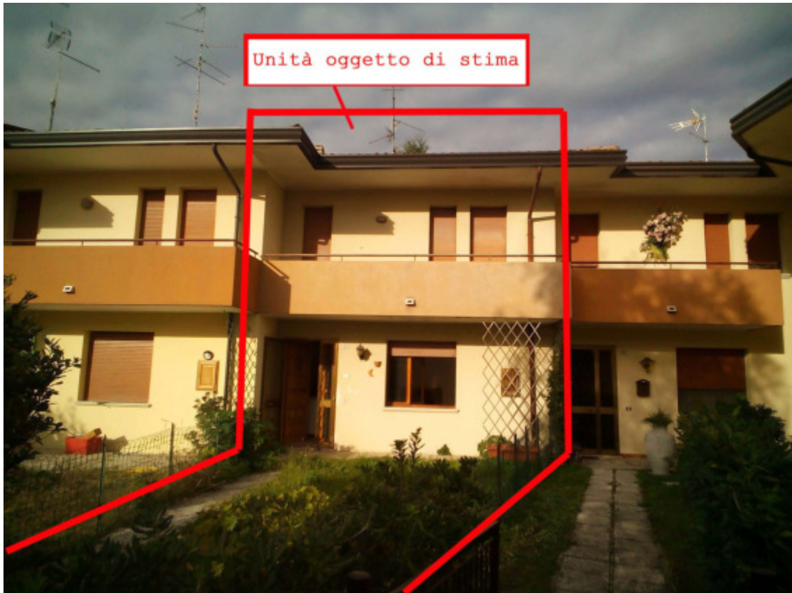
Veduta esterna da vialetto pedonale (lato sud)
