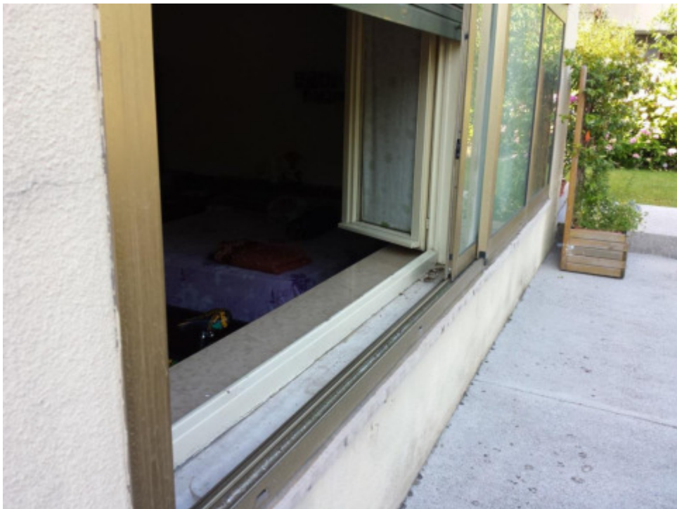
Tipologia serramenti esterni (vista esterna)
