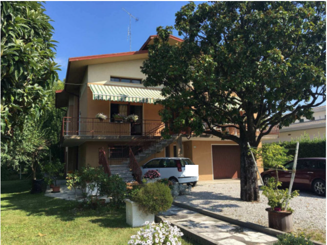
Foto n.3: Prospetti Sud ed Ovest del villino visto dal giardino di proprietà.
