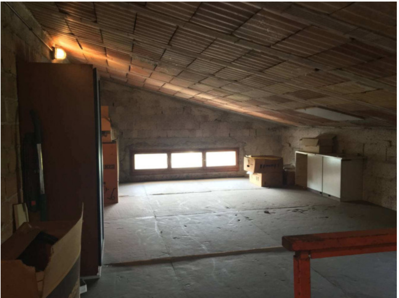
Foto n.26: Soffitta al Piano Secondo (Sub.2).
