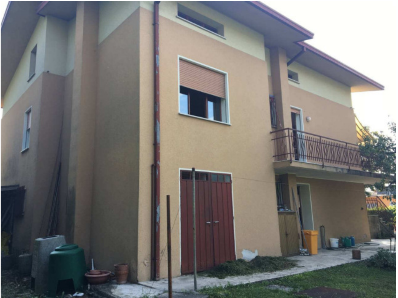
Foto n.5: Prospetti Nord ed Ovest del villino visto dal giardino di proprietà.
