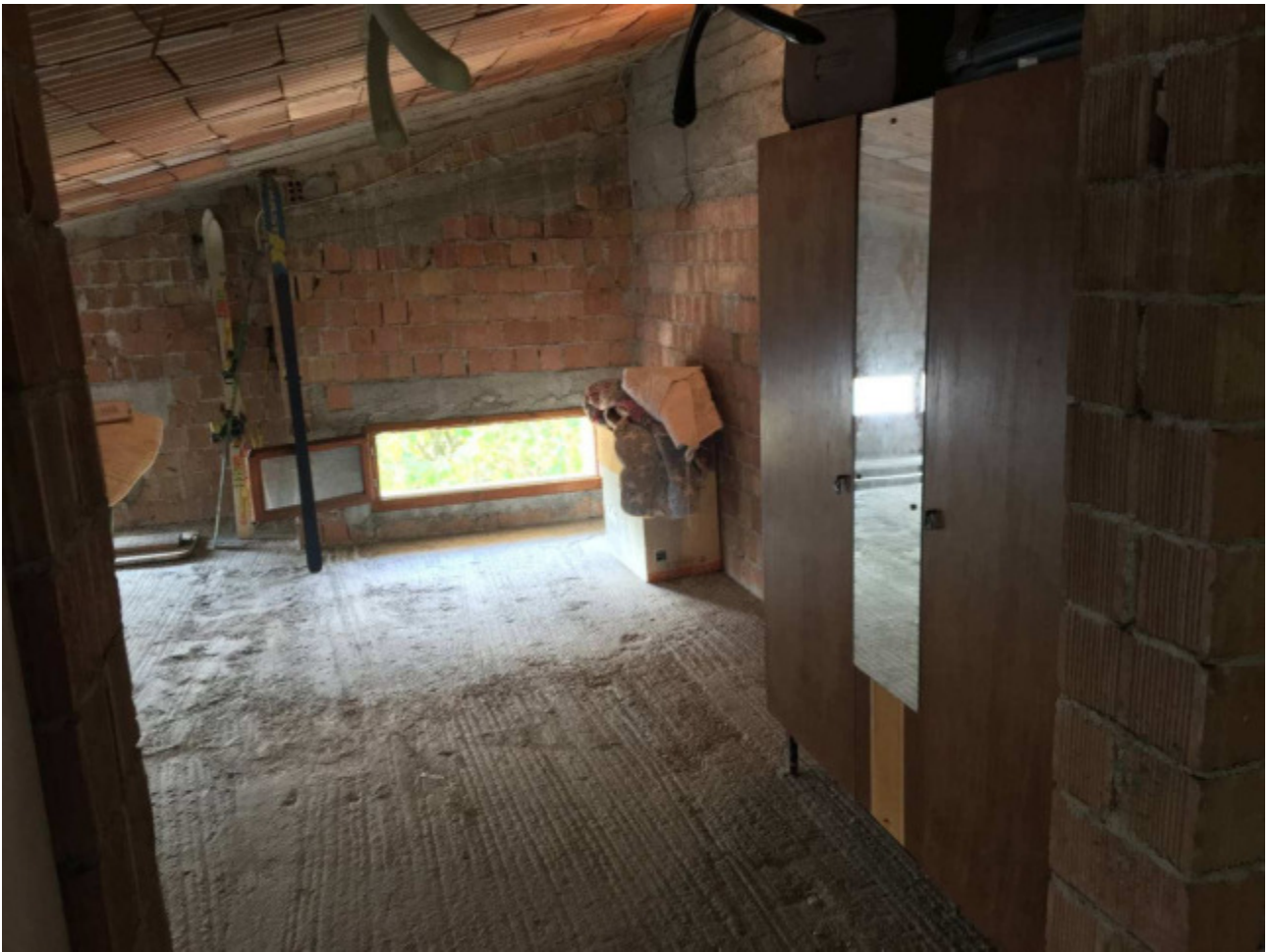
Foto n.25: Soffitta al Piano Secondo (Sub.2).
