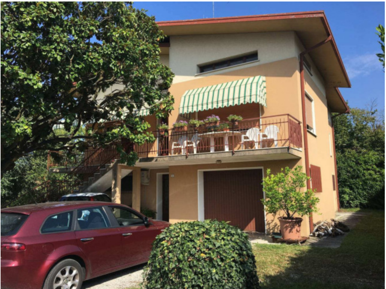
Foto n.4: Prospetti Sud ed Ovest del villino visto dal giardino di proprietà.
