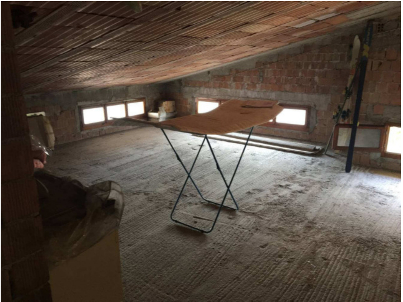
Foto n.27: Soffitta al Piano Secondo (Sub.2).
