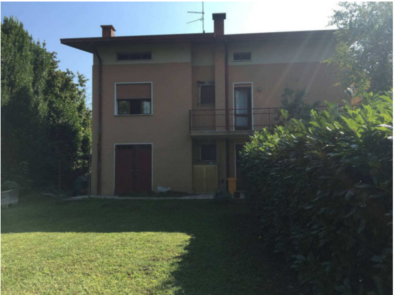
Foto n.6: Prospetto Ovest del villino visto dal giardino di proprietà.
