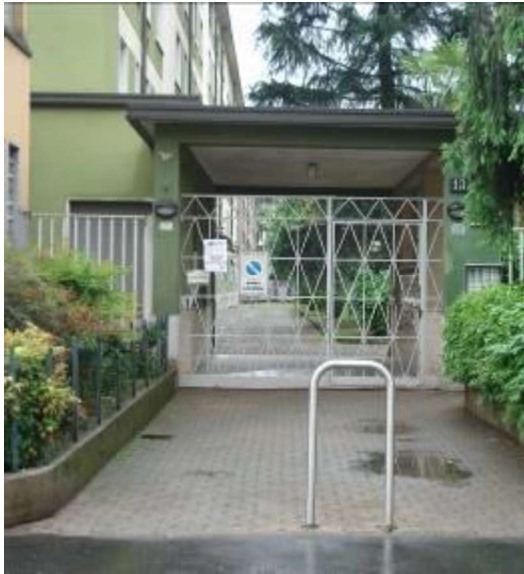
Ingresso sulla pubblica via
