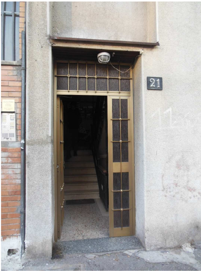
Portone di accesso all'immobile
