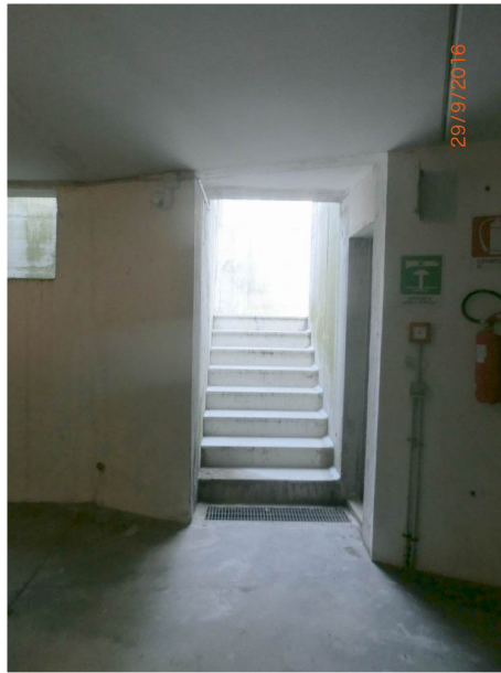
particolare interno della scala comune -subalterno 57-
