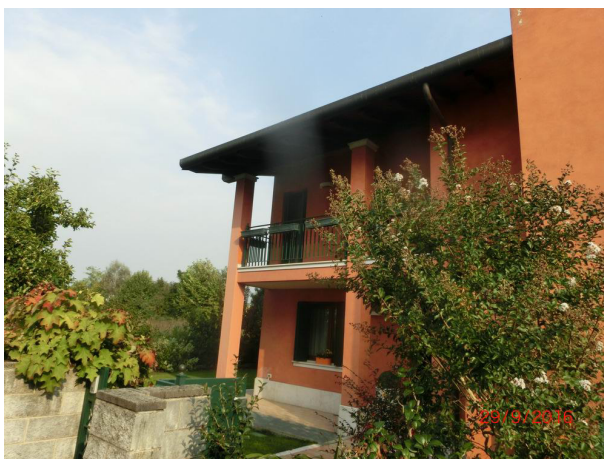
ulteriore particolare prospetto lato Ovest
