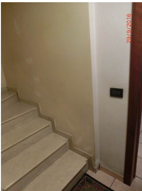
particolare interno della scala di accesso al piano terra
