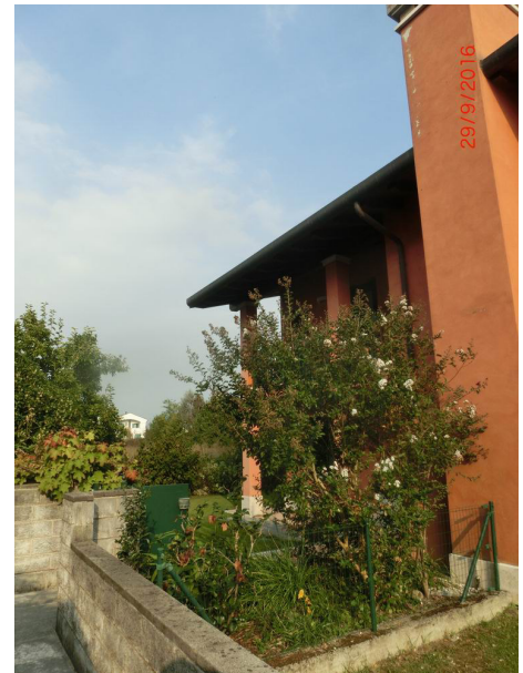
particolare accesso pedonale -lato Ovest-
