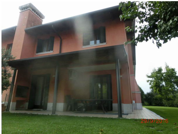
particolare prospetto retro fabbricato -lato Est-
