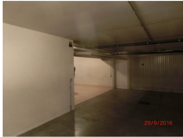
particolare ingresso del locale garage
