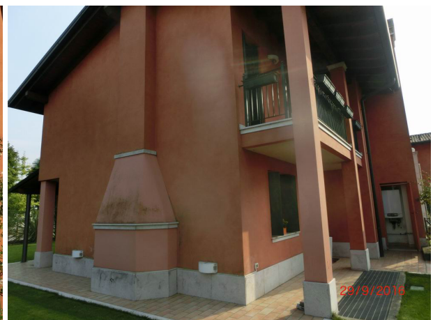
ulteriore particolare prospetto lato Nord/Ovest
