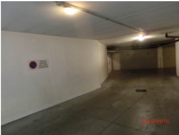
particolare interno del locale comune spazio di manovra -subalterno 57-
