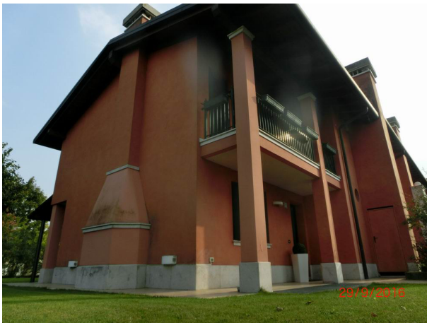
Particolare prospetto principale -lato Nord/Ovest-
