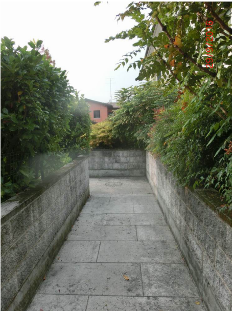
ulteriore particolare passaggi e camminamenti -sub. 58-
