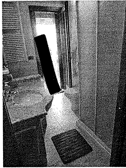
particolare interno del locale bagno
