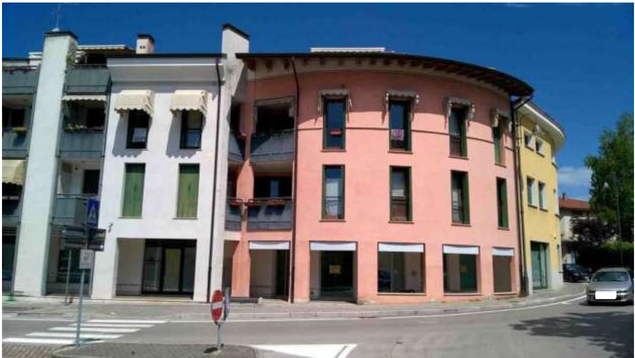
fronte principale su via Cantore
