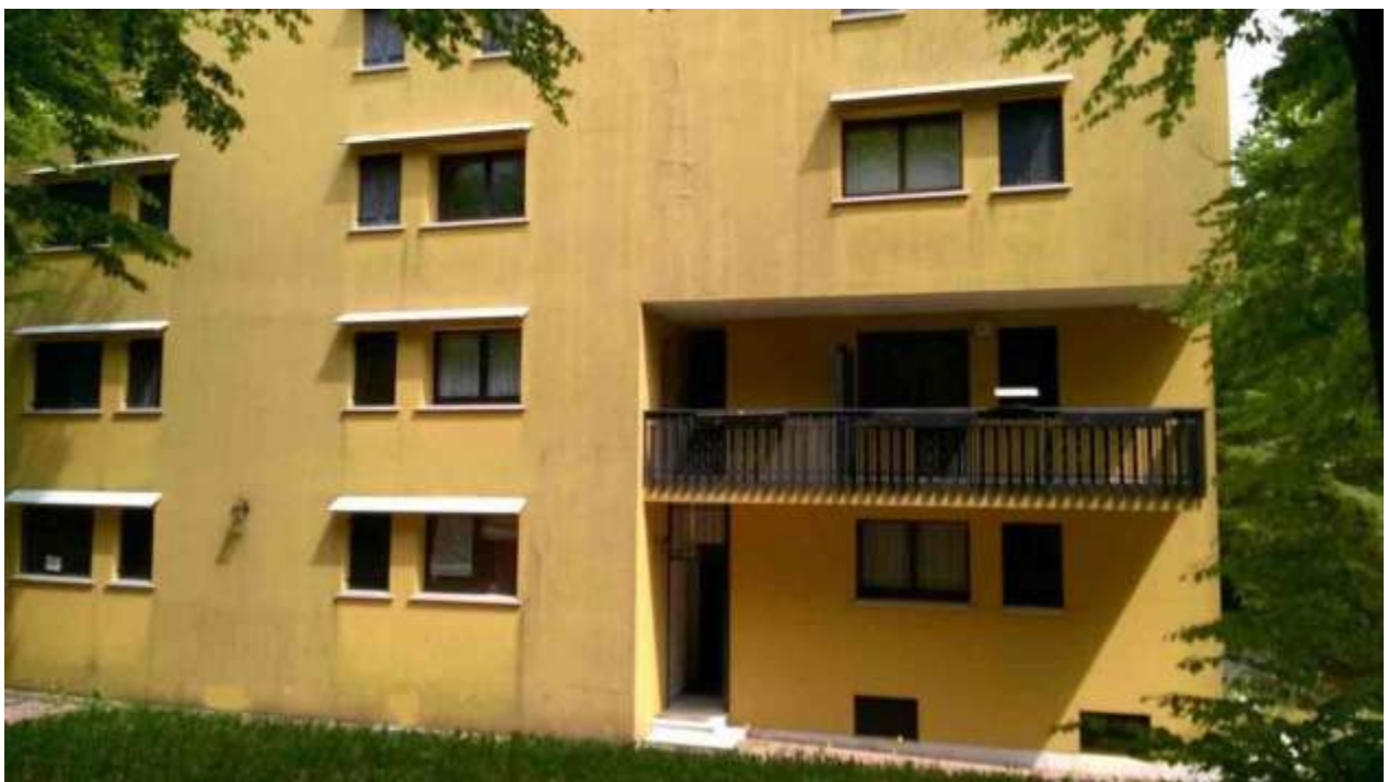
prospetto ovest sull'ingresso
