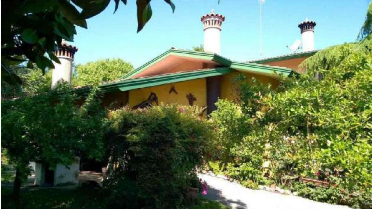
accesso carraio fronte nord su via Aquileia
