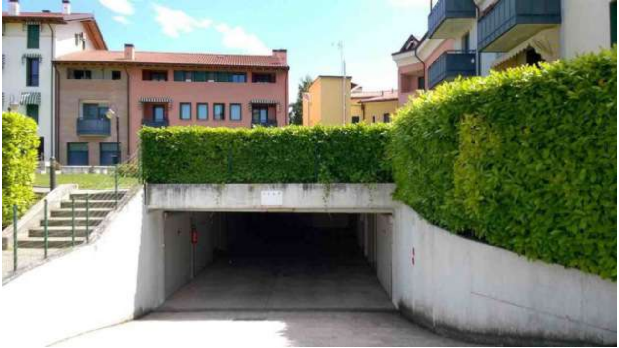
accesso ai garage interrati
