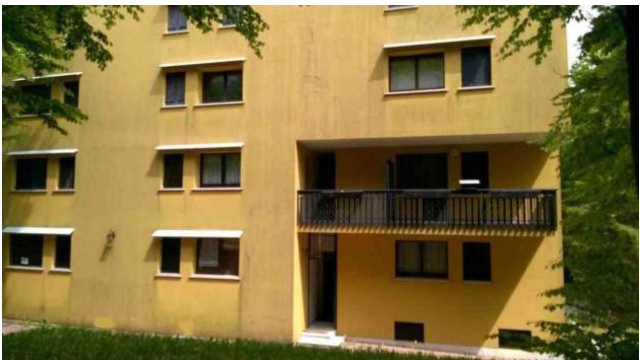
prospetto ovest sull'ingresso
