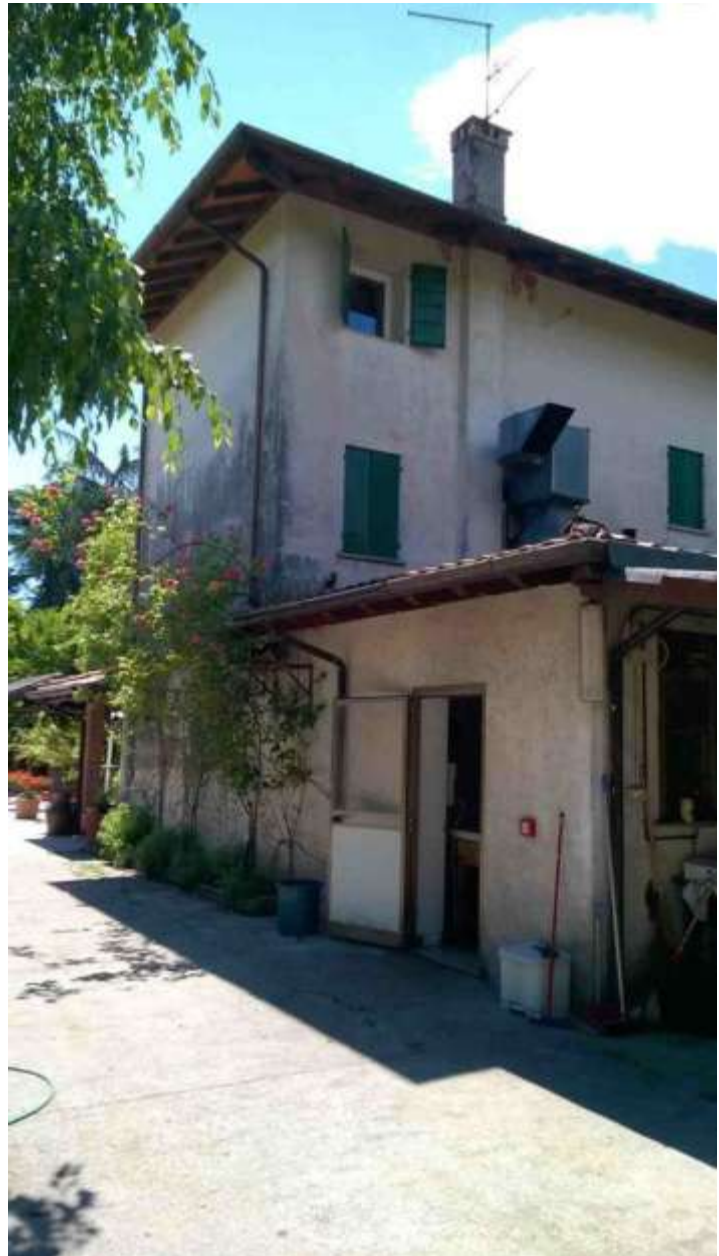
fronte est su via Prà
