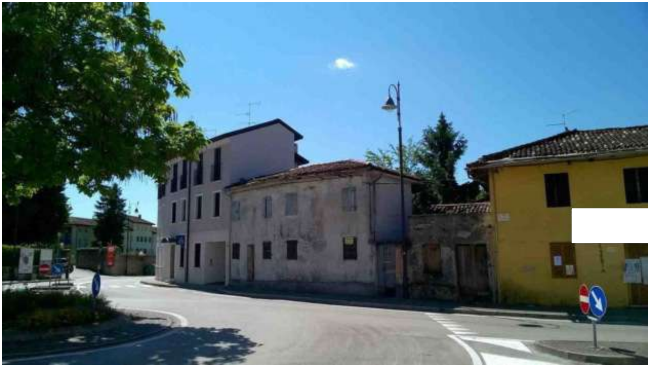
fronte principale su via Cantore
