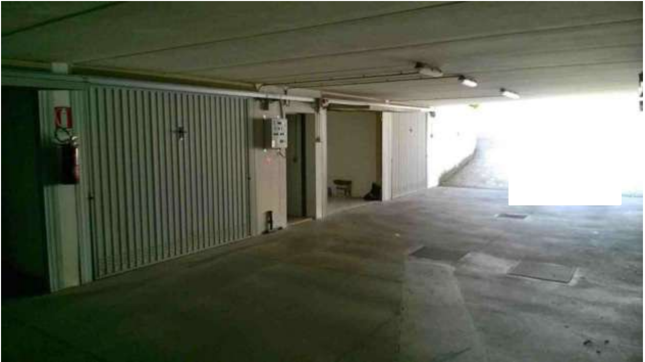
interrato rampa accesso e spazio manovra
