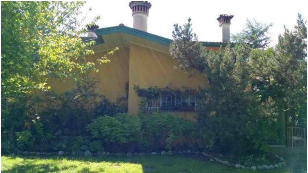
fronte ovest giardino interno
