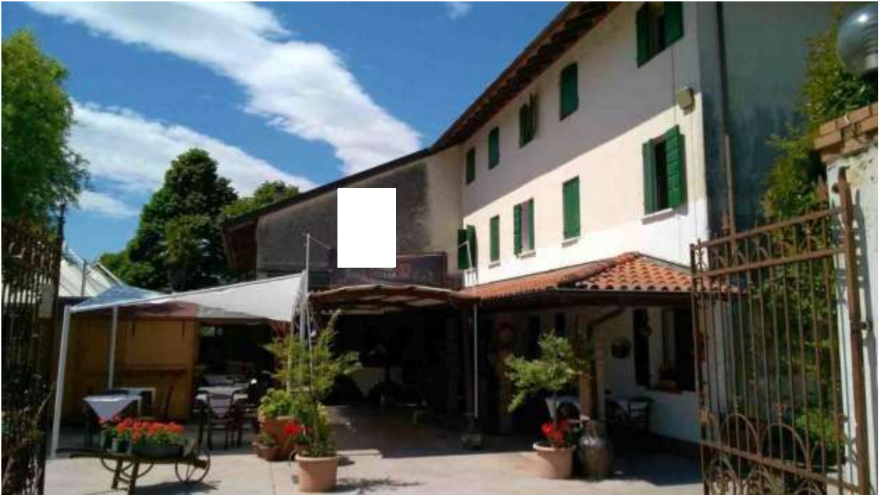
accesso da via Prà
