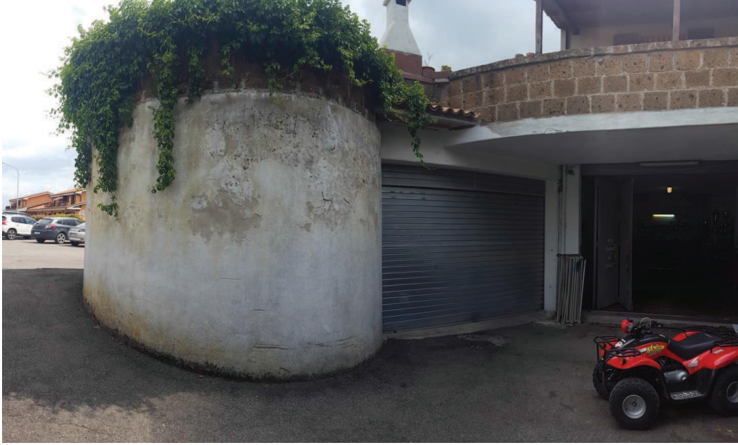
Ingresso pedonale dall'esterno ed al garage
