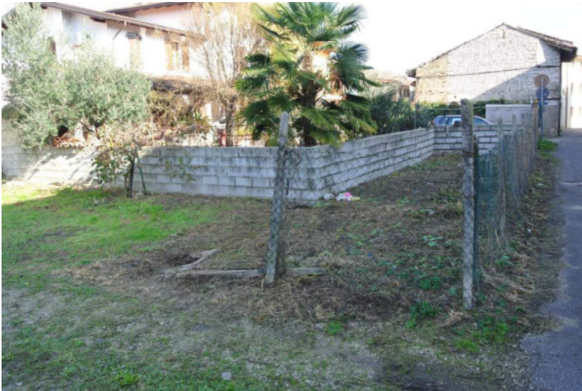
RECINZIONE SU TERRENO B
