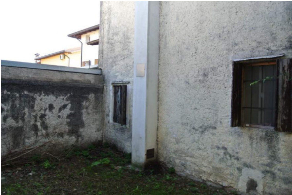
ABITAZIONE PRINCIPALE (PROSPETTO NORD-OVEST)
