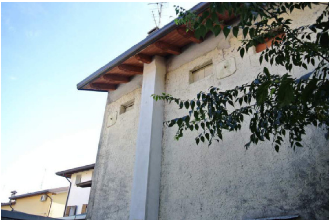
ABITAZIONE PRINCIPALE (PROSPETTO NORD-OVEST)
