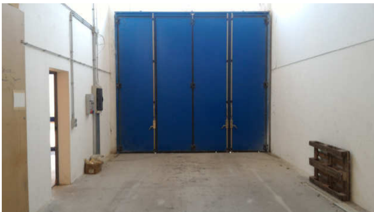
FOTO N.12 FOGLIO 15, MAPPALE 629 COMUNE DI FOSSALTA DI PORTOGRUARO (VE)
