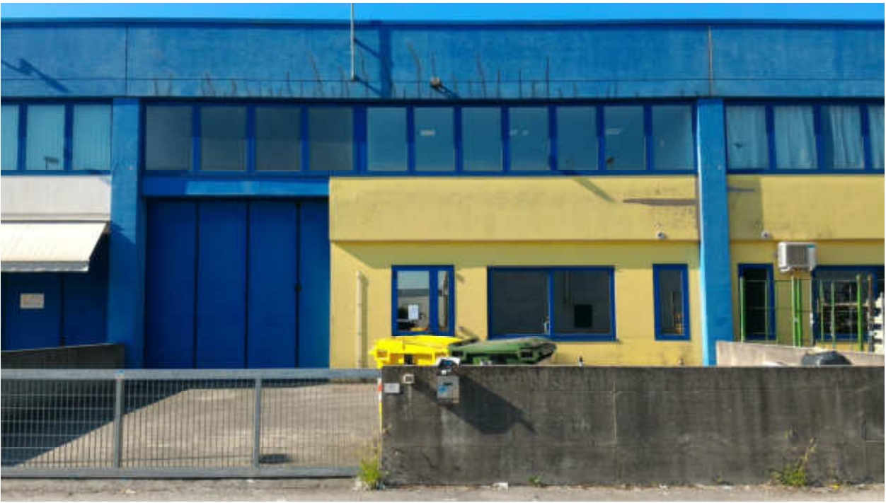
FOTO N.02 FOGLIO 15, MAPPALE 629 COMUNE DI FOSSALTA DI PORTOGRUARO (VE)
