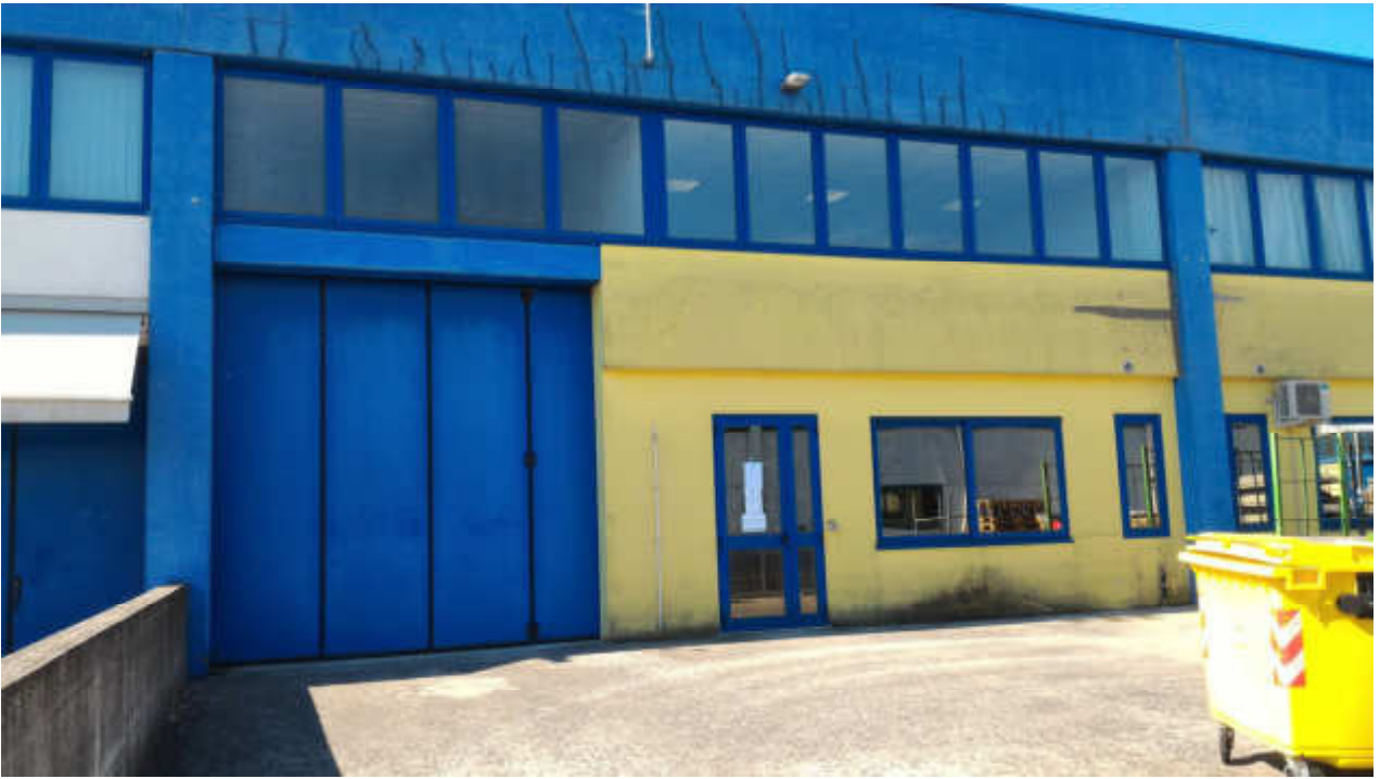
FOTO N.04 FOGLIO 15, MAPPALE 629 COMUNE DI FOSSALTA DI PORTOGRUARO (VE)
