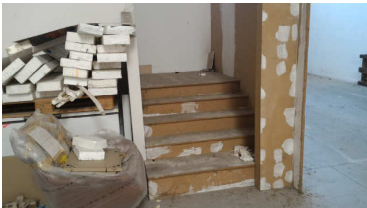
FOTO N.14 FOGLIO 15, MAPPALE 629 COMUNE DI FOSSALTA DI PORTOGRUARO (VE)
