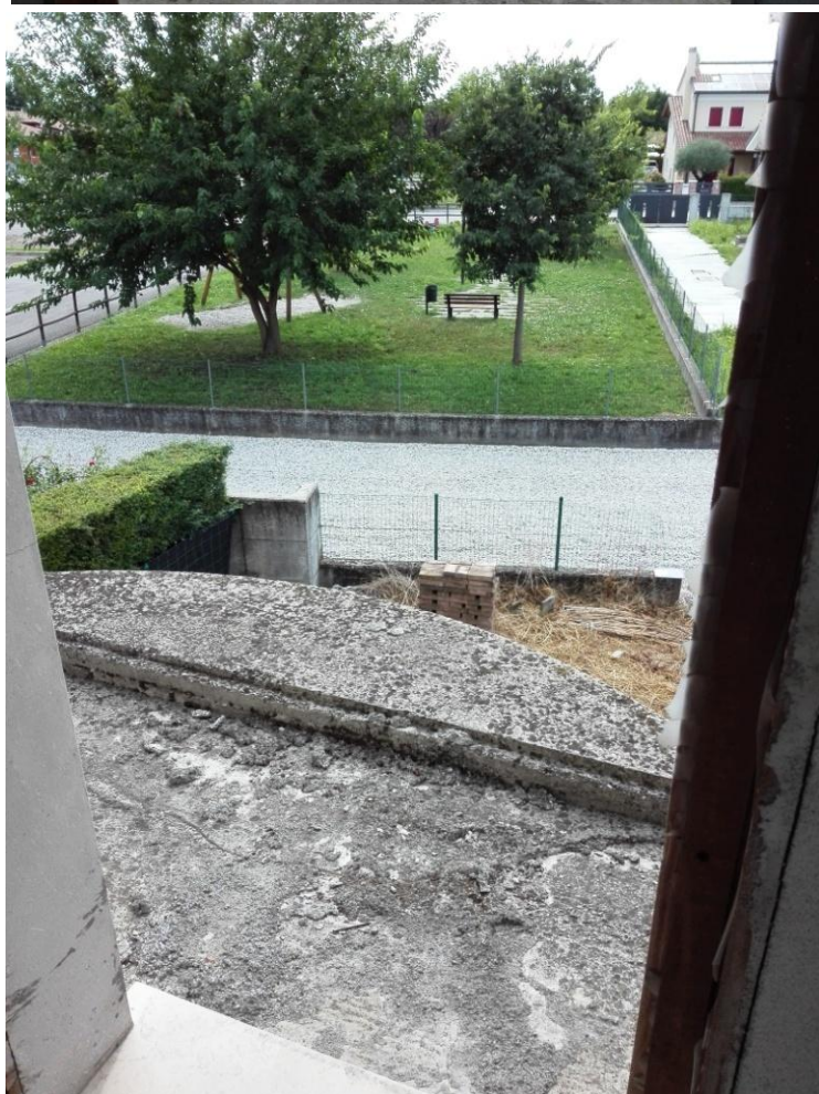
Terrazzino camera matrimoniale
