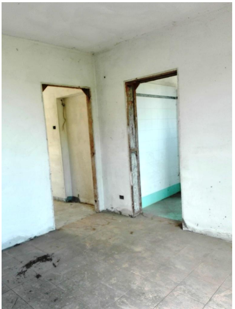
Cucina verso lavanderia
