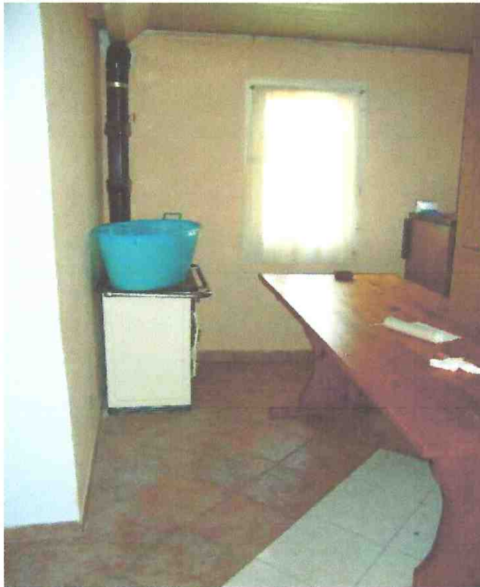
Illustrazione 13: Particolare interno ampliamento abusivamente realizzato
