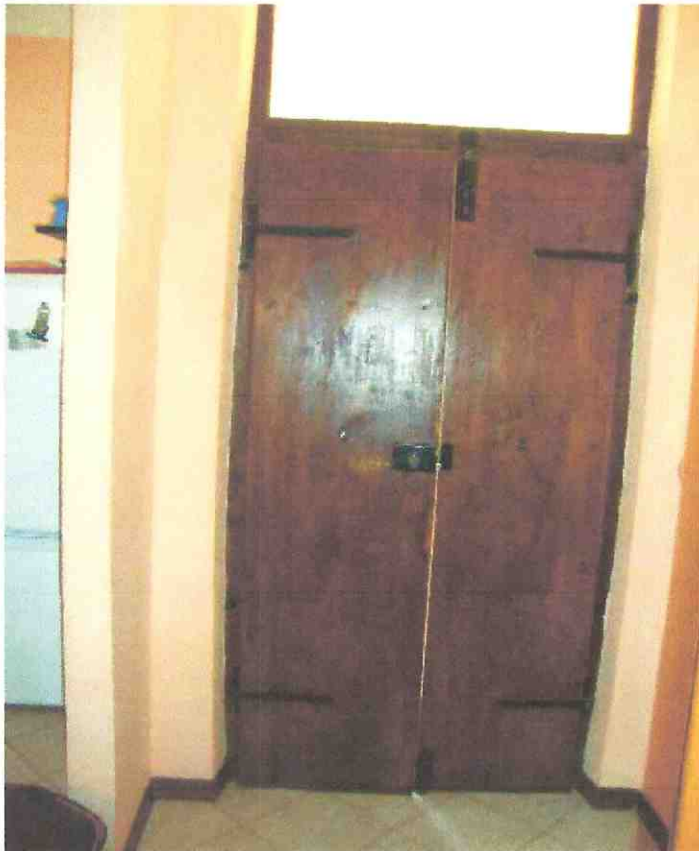
Illustrazione 9: Portone ingresso vista interna
