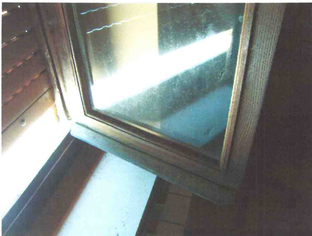
Illustrazione 17: Particolare infissi esterno
