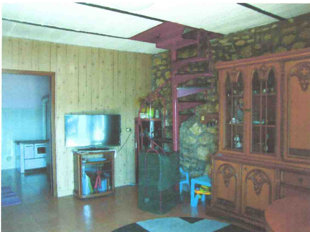
Illustrazione 6: Soggiorno con particolare della scala a chiocciola di collegamento all'appartamento superiore da demolire
