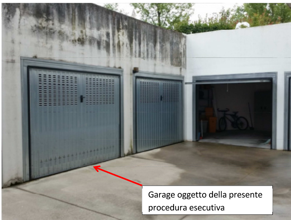
Vista esterna garage
