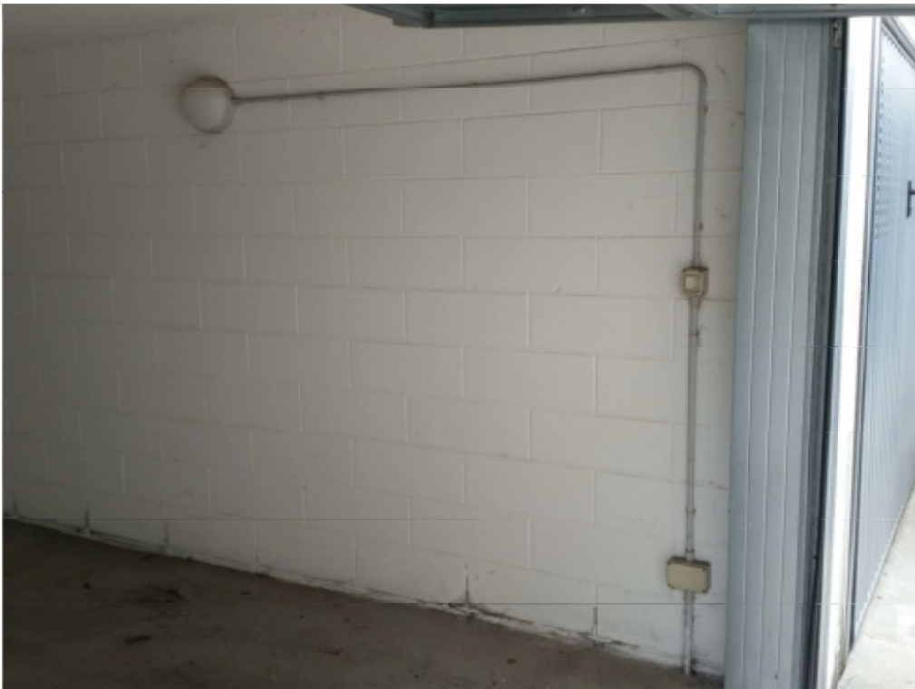
Particolare interno garage
