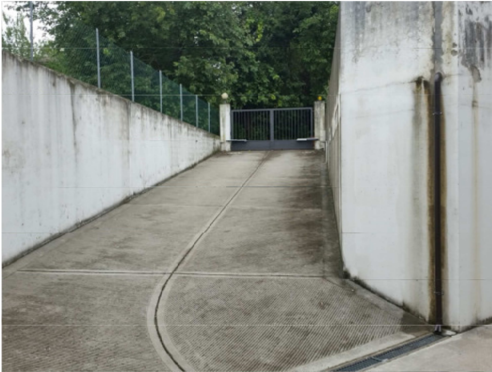
Rampa che dal corsello di manovra conduce all'accesso carraio
