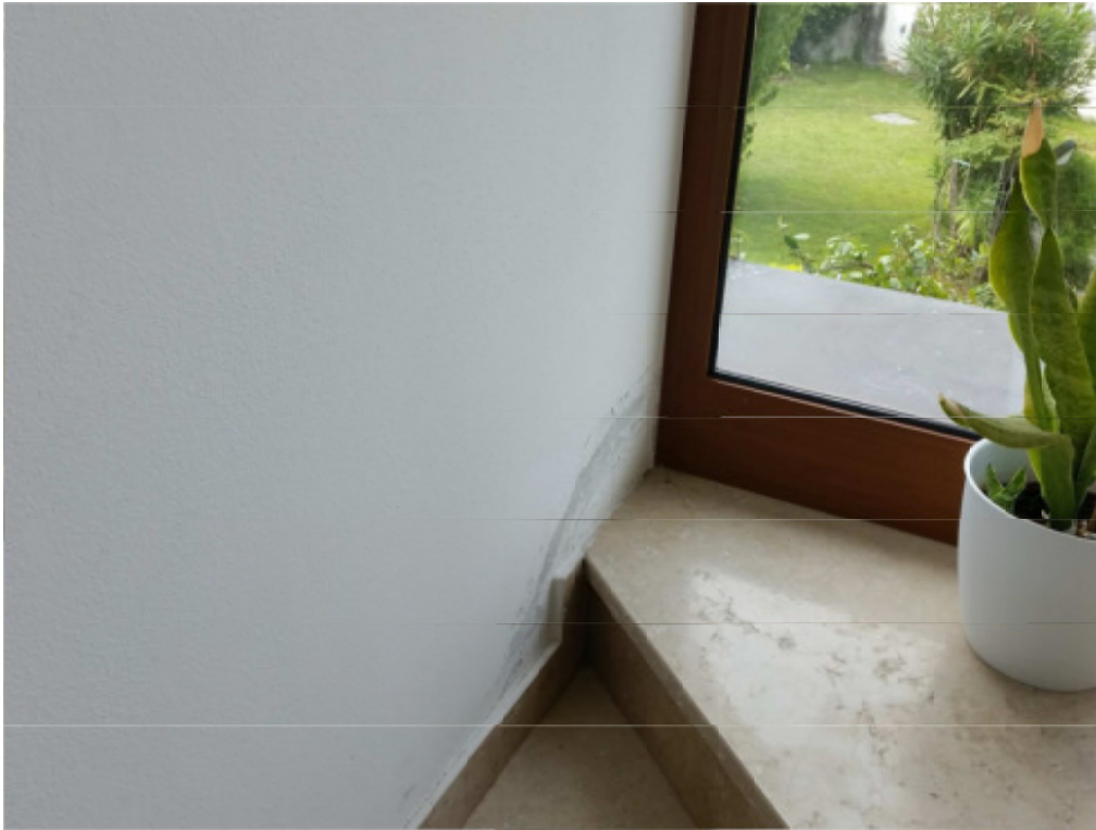
Problematiche di infiltrazione in corrispondenza del portoncino di ingresso al condominio
