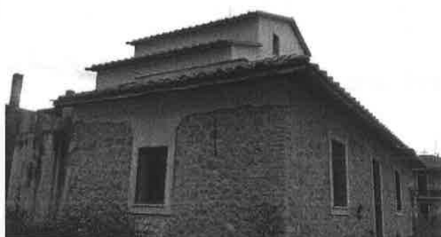
Vista esterna intero edificio
