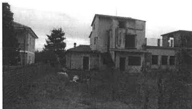
Vista esterna intero edificio
