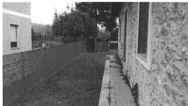
Vista esterna intero edificio
