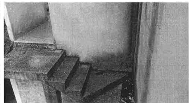
Scala di accesso all'unità immobiliare
