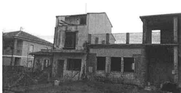
Vista esterna intero edificio
