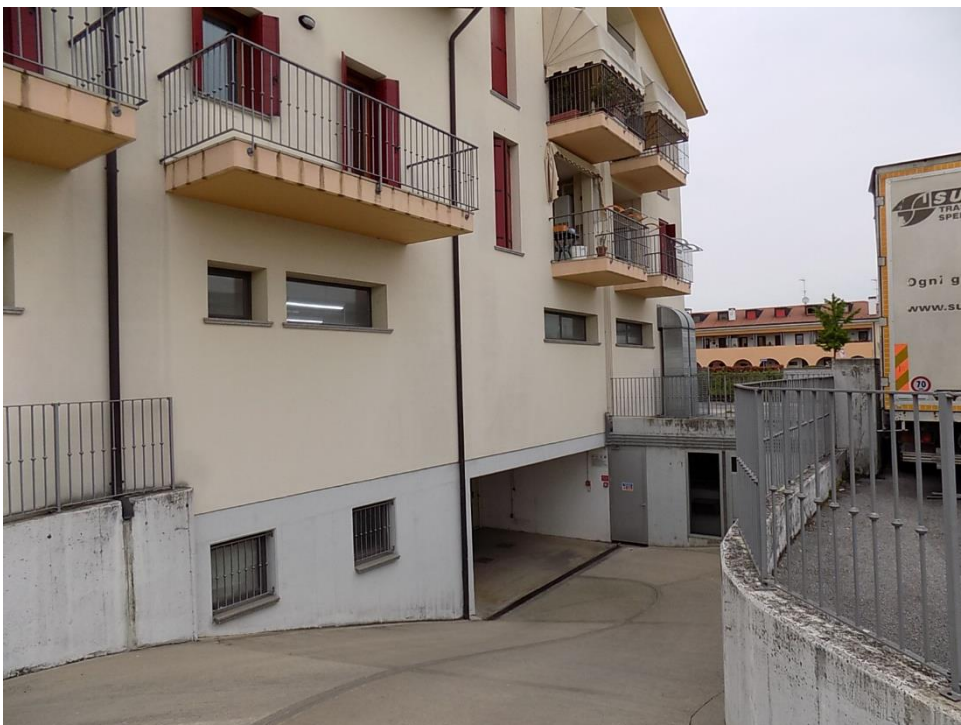
Foto 8 – Esterno dell'appartamento e rampa di accesso condominiale ai garage
