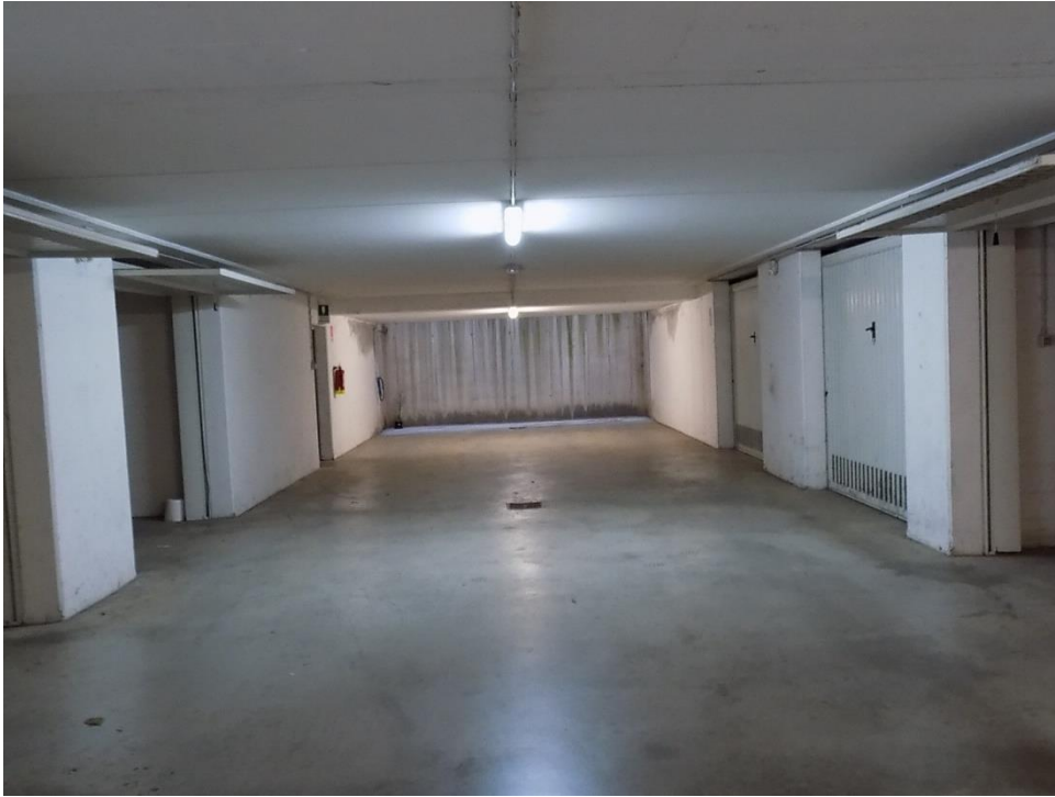
Foto 9 – corsia auto al piano interrato
