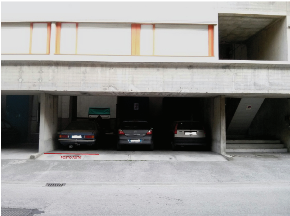
Posto auto e scala di accesso
