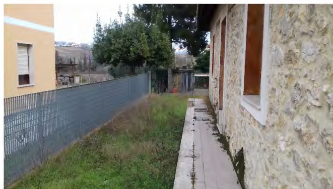
Vista esterna intero edificio
