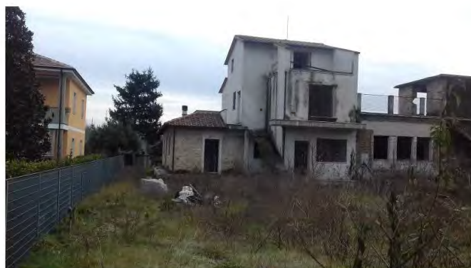
Vista esterna intero edificio
