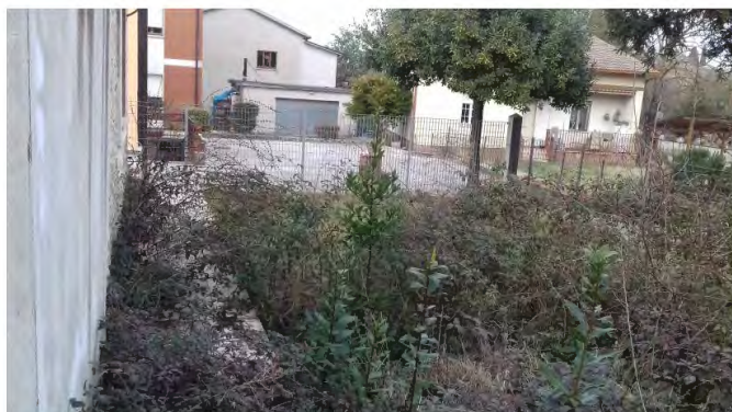
Vista esterna intero edificio
