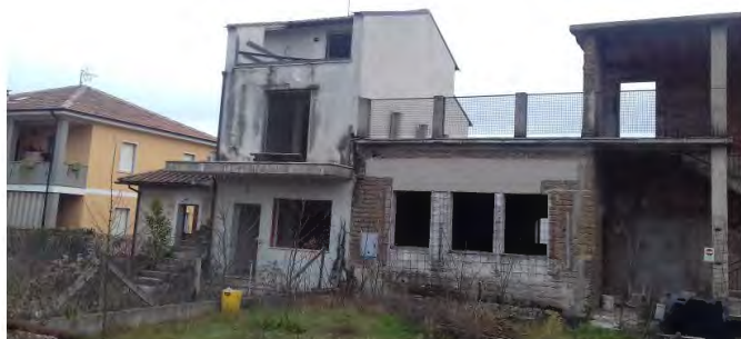
Vista esterna intero edificio
