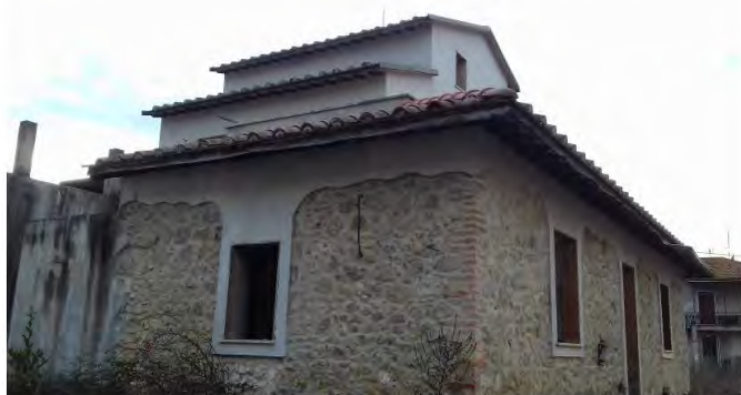
Vista esterna intero edificio
