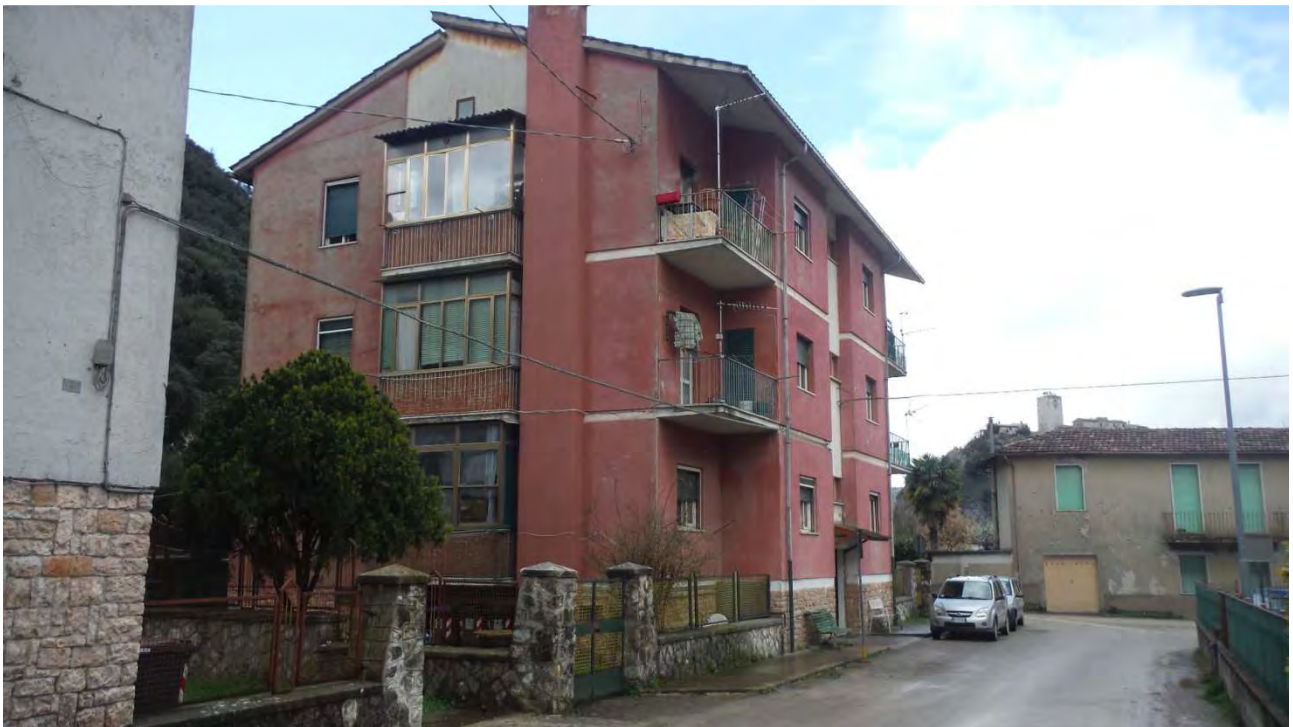
Foto 2 prospetto nord-est (alloggio al piano secondo – si noti la chiusura a vetri della loggia, condonata)
