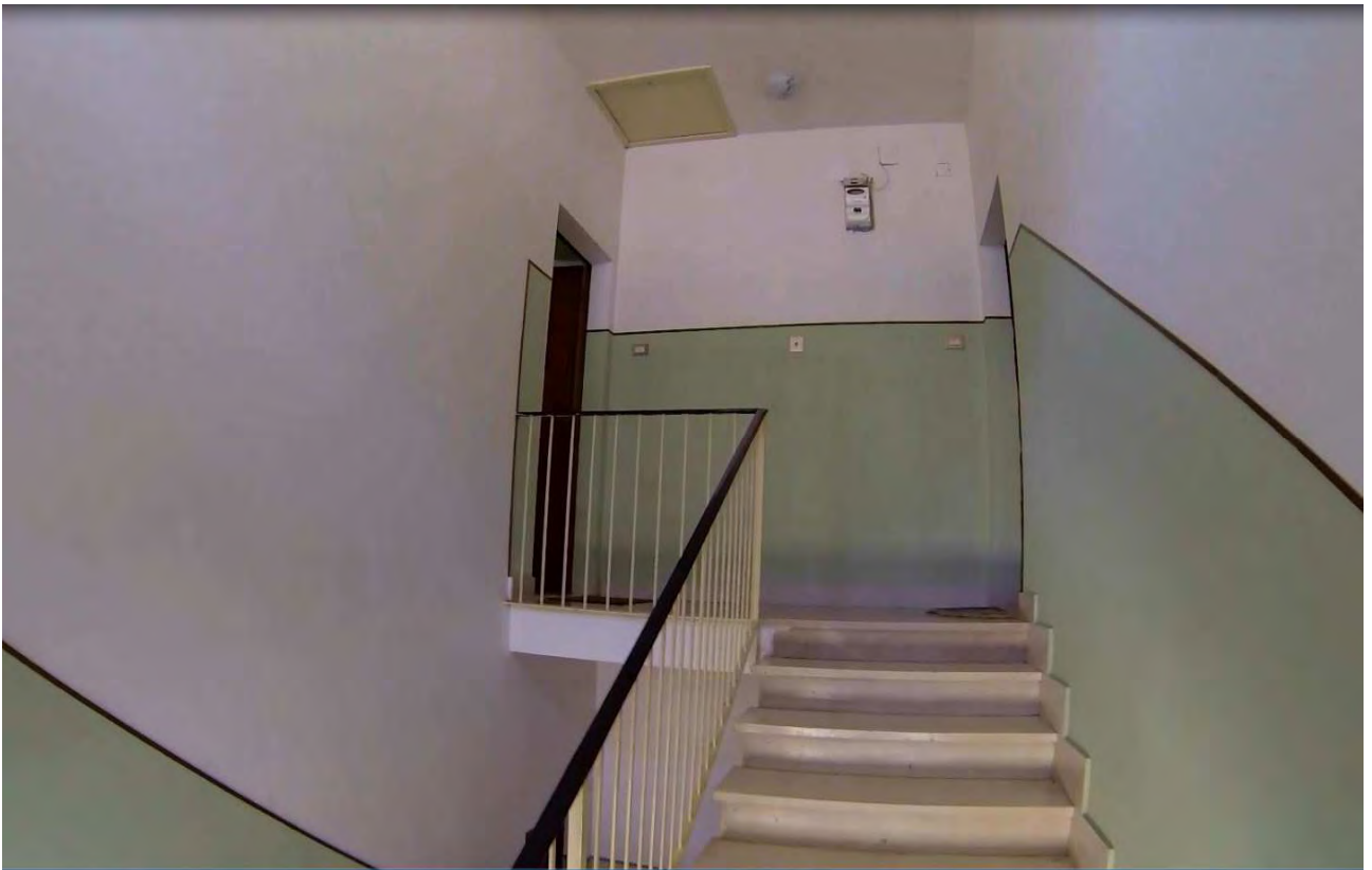
Foto 4 vista del pianerottolo di ingresso al piano secondo
