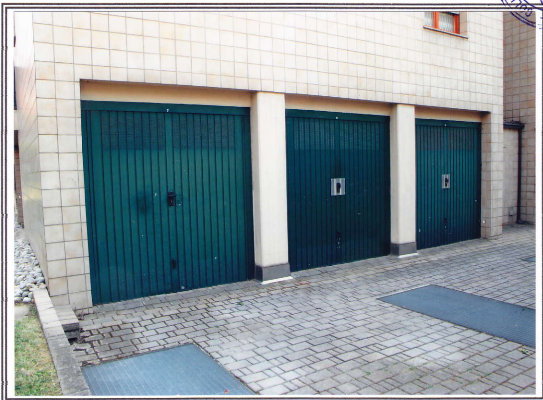
Esterno edificio "A" – esterno box autorimessa
