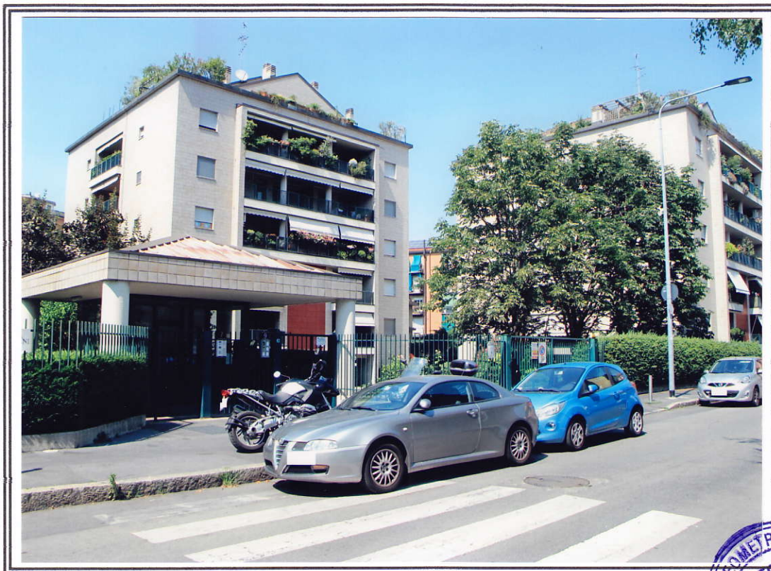
Esterno complesso immobiliare civico 9
