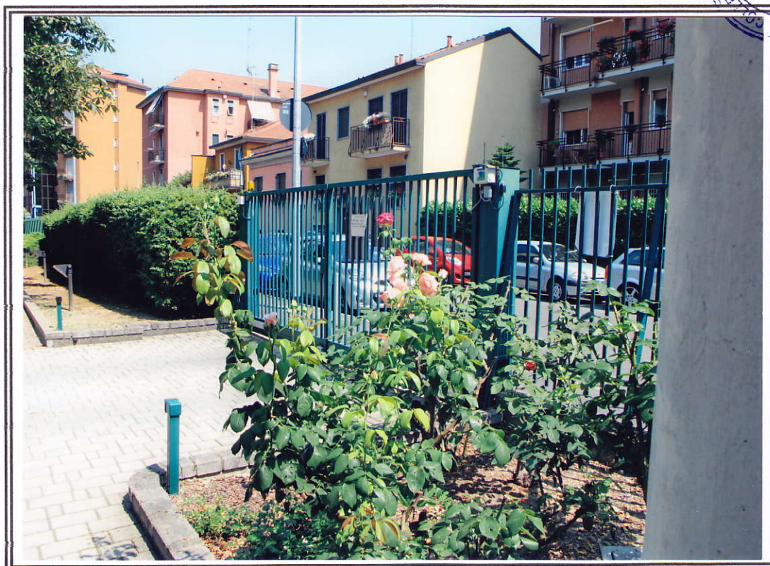
Esterno complesso immobiliare civico 9 – ingresso carrabile
