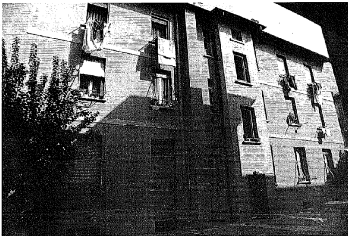
Facciata dello stabile (Fabbricato B)
