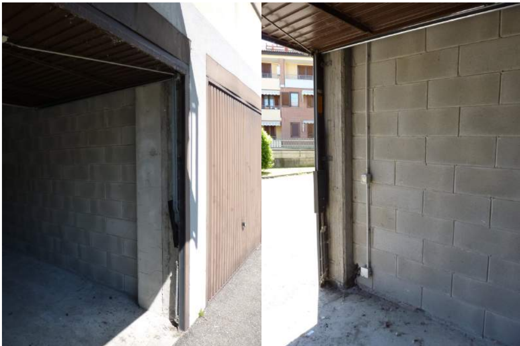
Lotto 3 - locale ad uso box - particolari interni
