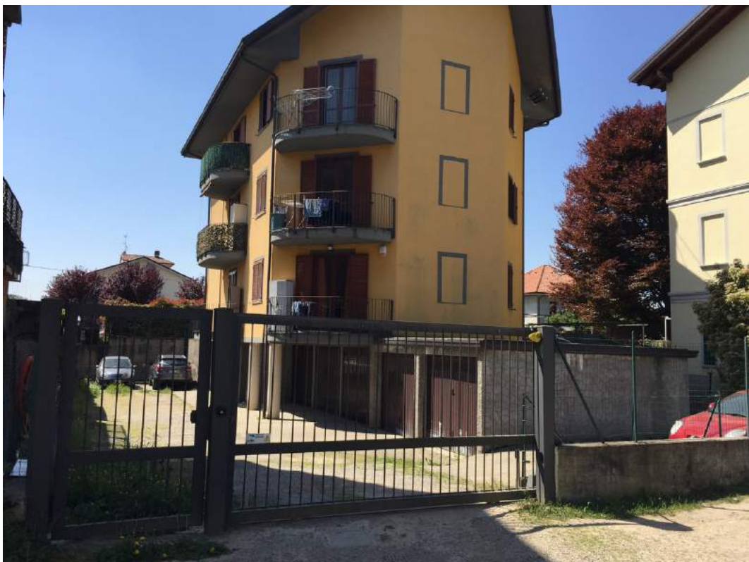
L'ingresso carraio e pedonale del fabbricato
