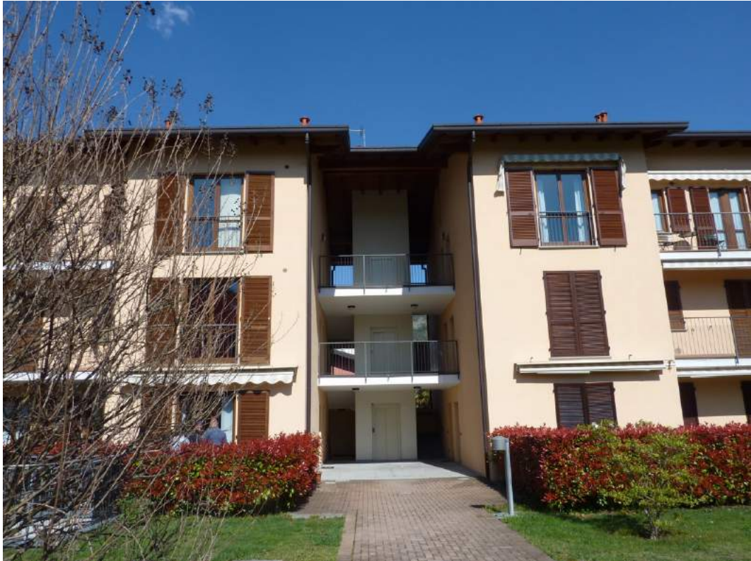
Il fronte dal giardino interno
