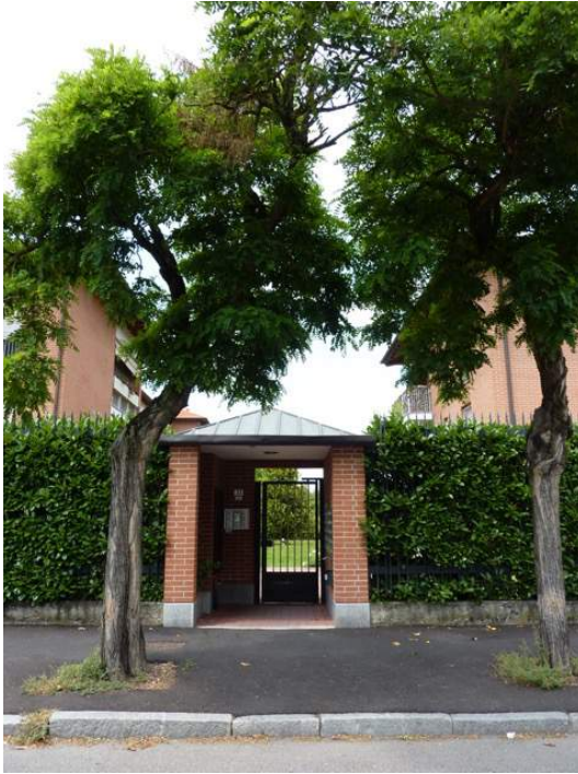
L'ingresso pedonale da Via Gramsci
