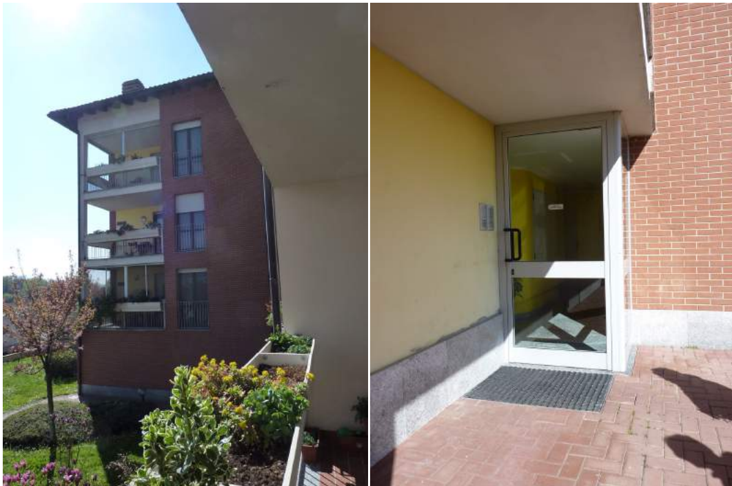
L'edificio visto dal balcone al piano primo e l'ingresso condominiale
