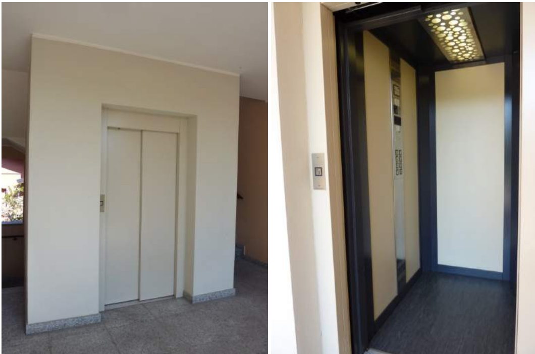
Il vano ascensore
