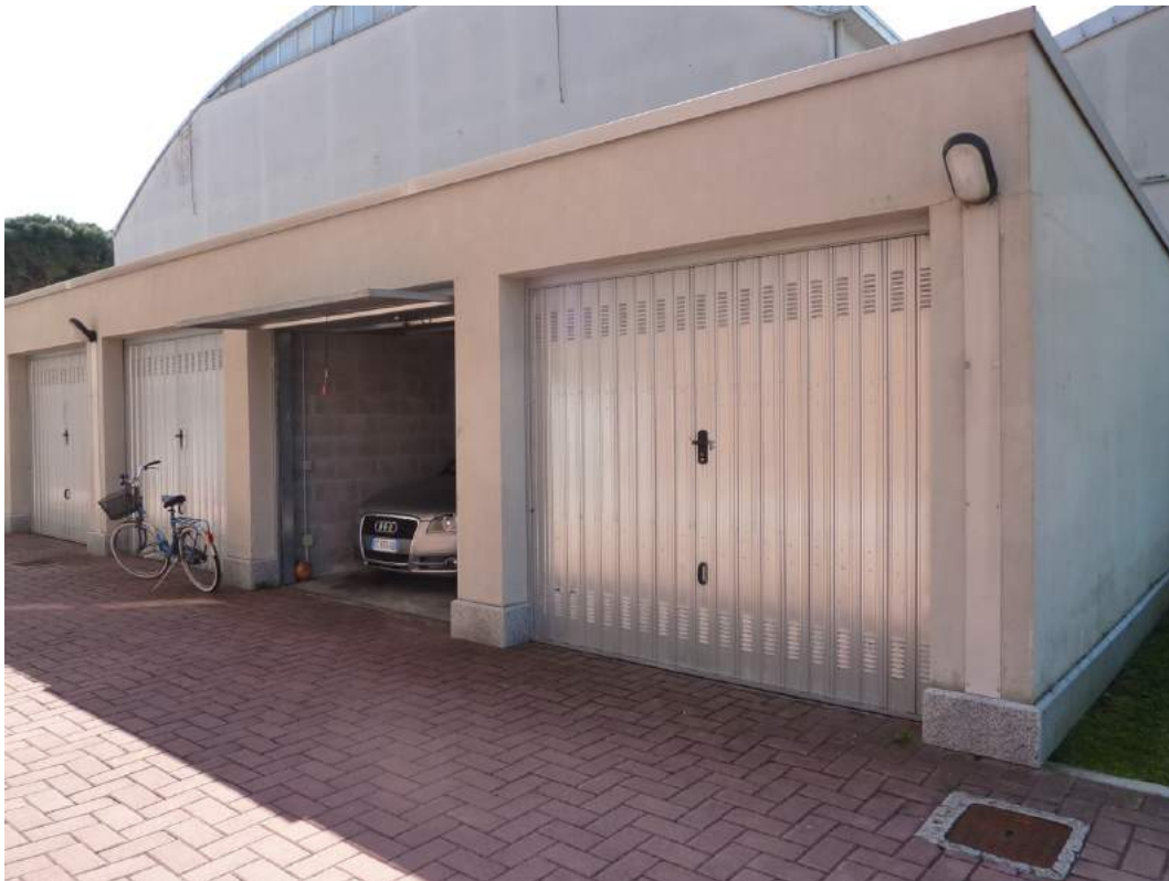
Il locale ad uso autorimessa
