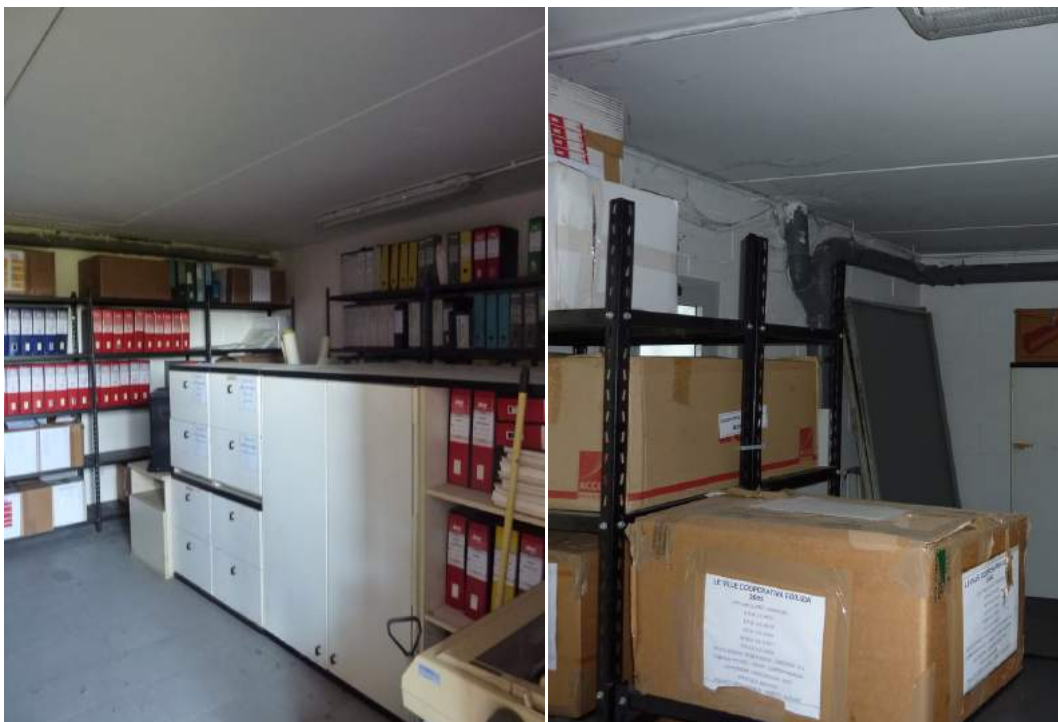
Il deposito, Lotto 6, con presenza di tubazioni di scarico condominiali
