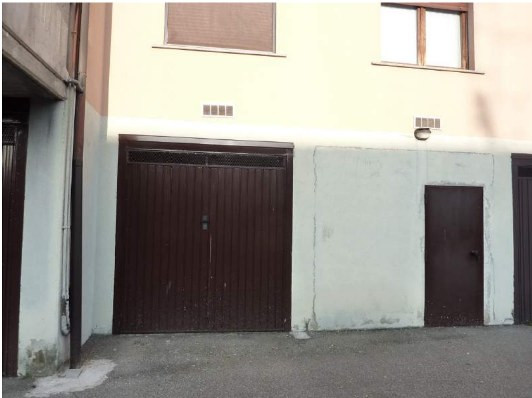
Il locale ad uso box - Lotto 10
