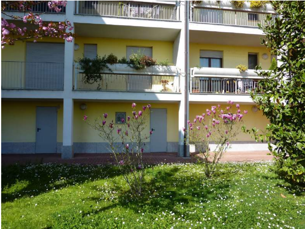
L'ingresso al deposito del Lotto 6
