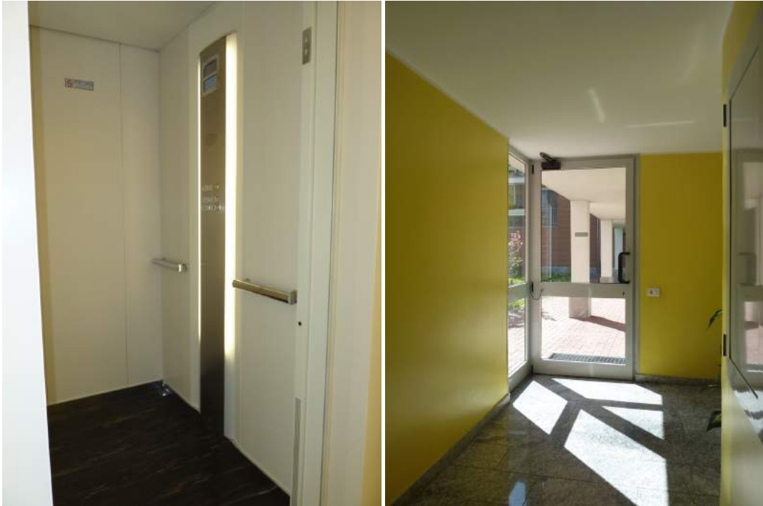
Vano ascensore e l'ingresso condominiale visto dall'interno per il Lotto 5
