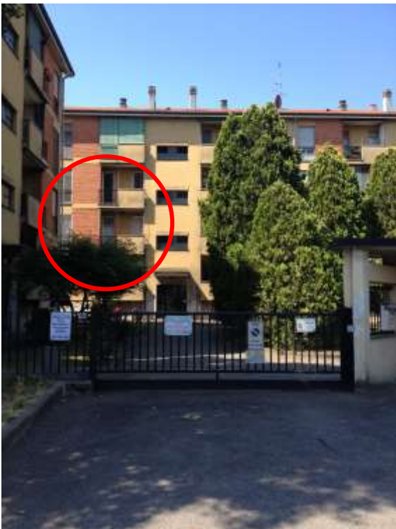
Foto 2. Vista complessiva della facciata di ingresso prospiciente la via Madonna del Salvatore 6 con in evidenza l'unità oggetto della stima.
