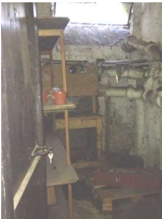
Foto 12. Vista della cantina.
