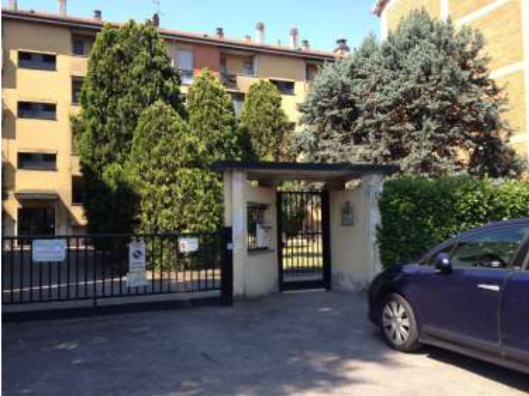
Foto 1. Vista complessiva della facciata di ingresso prospiciente la via Madonna del Salvatore 6.
