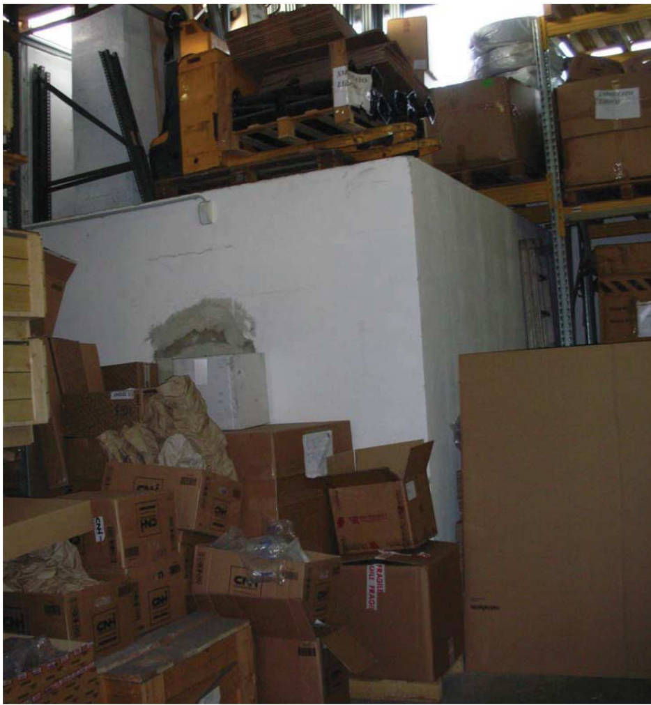
Foto n. 7 – Veduta esterna della centrale termica
