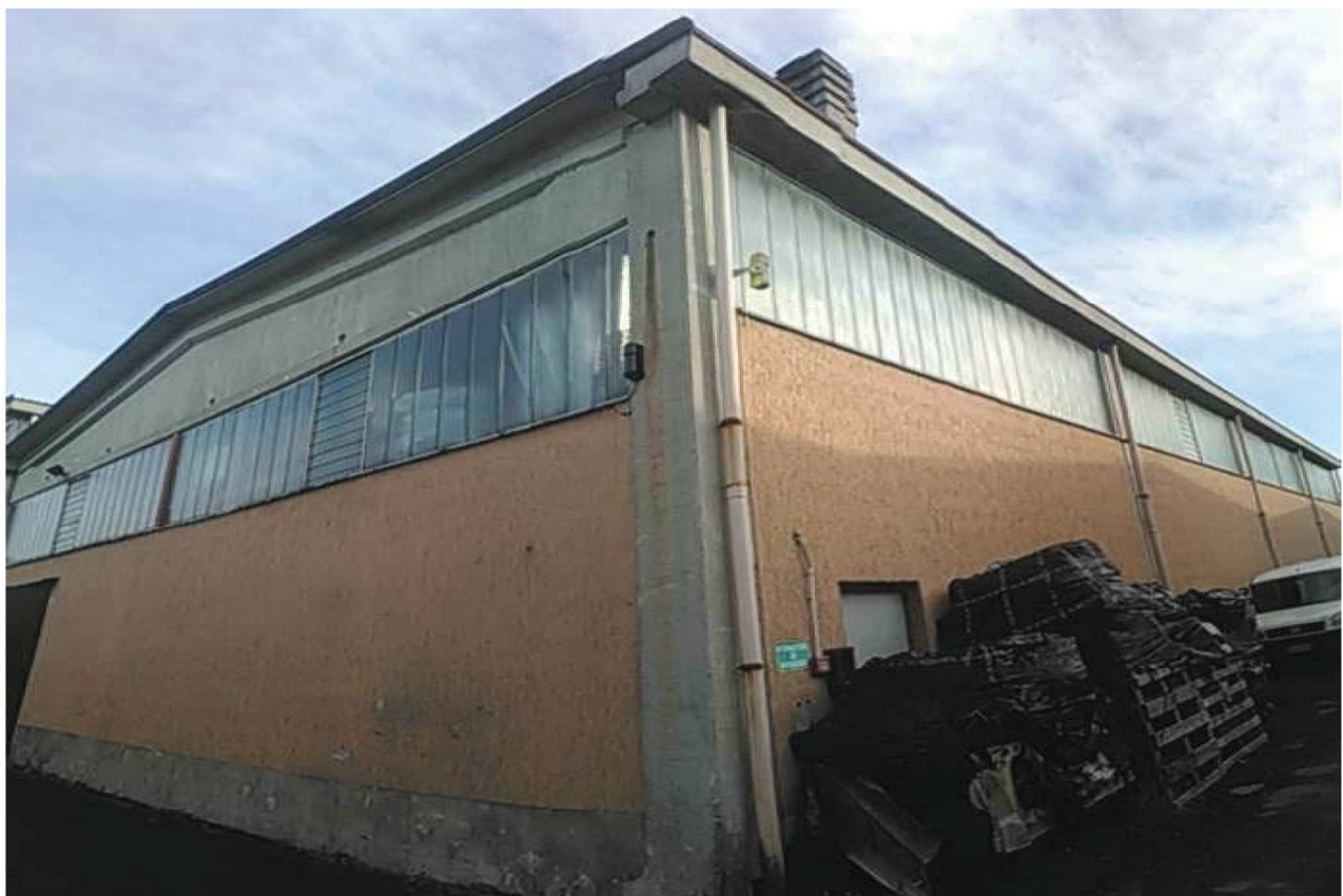
Foto n. 2 – Prospetto retrostante del Capannone Industriale
