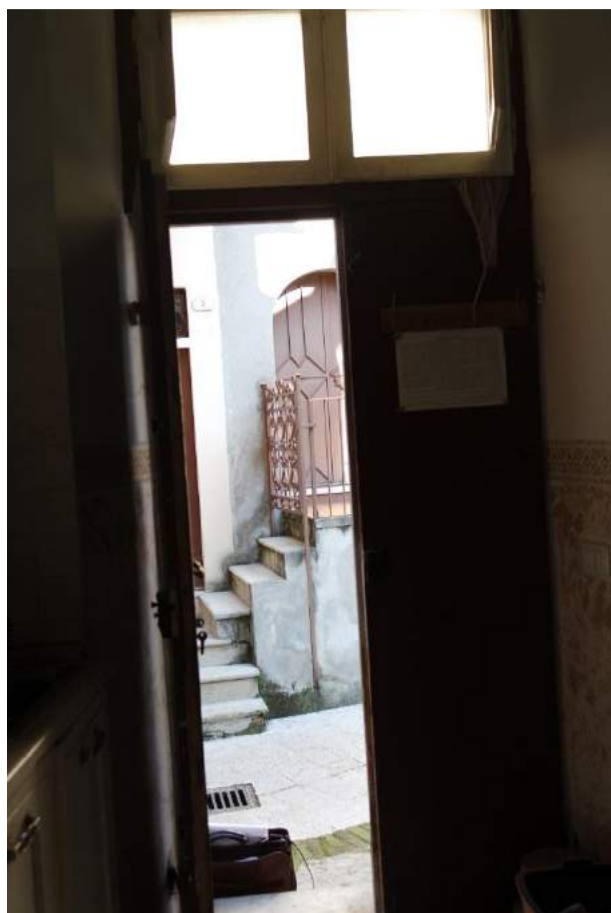
Vista 6 – Piano terra: portoncino di ingresso, vista interna
