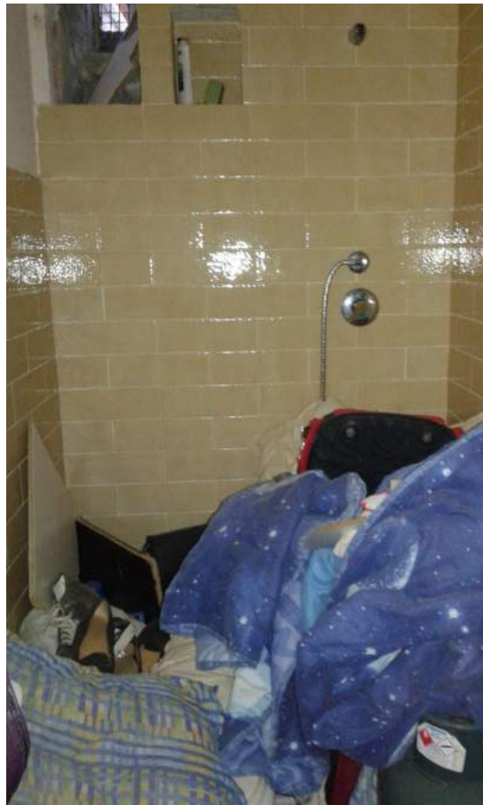
Vista 16 - Piano terra- locale bagno
