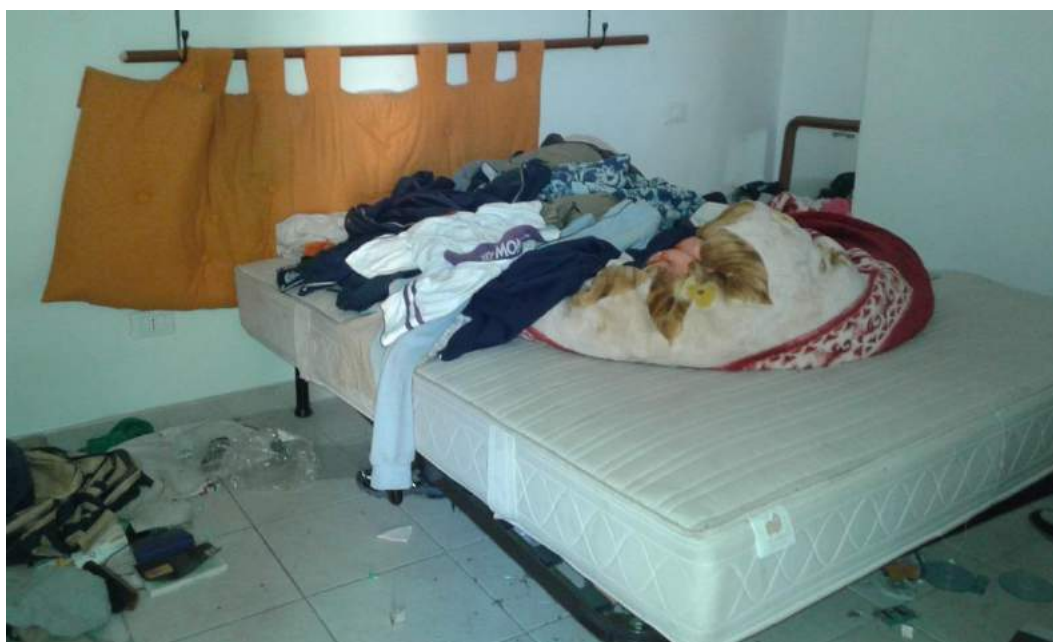
Vista 9 - Piano primo: camera cieca
