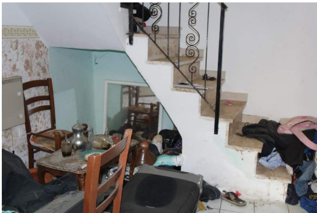
Vista 5 – Piano terra: Ingresso nella cucina-pranzo
