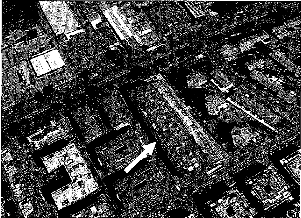
Immobile sito alla Via Tiburtina n. 654/A
