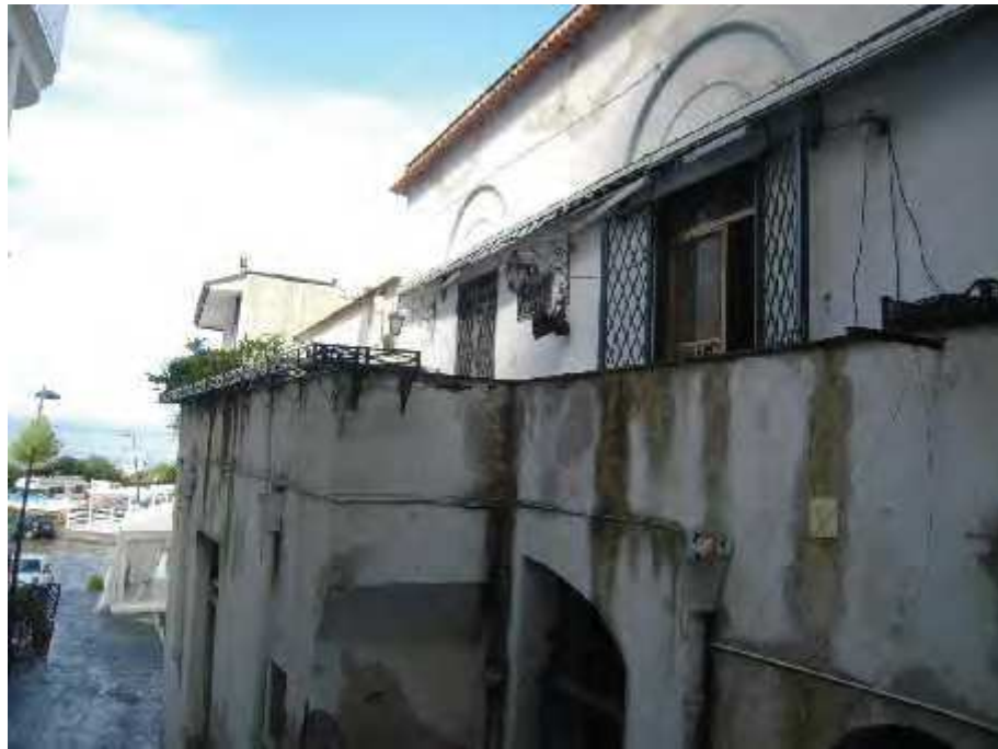
Figura 1 - Vista edificio dall'esterno
