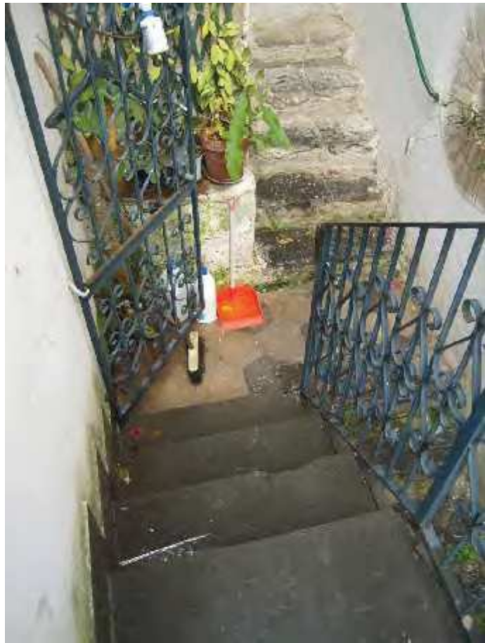
Figura 13 - Vista scale esterne
