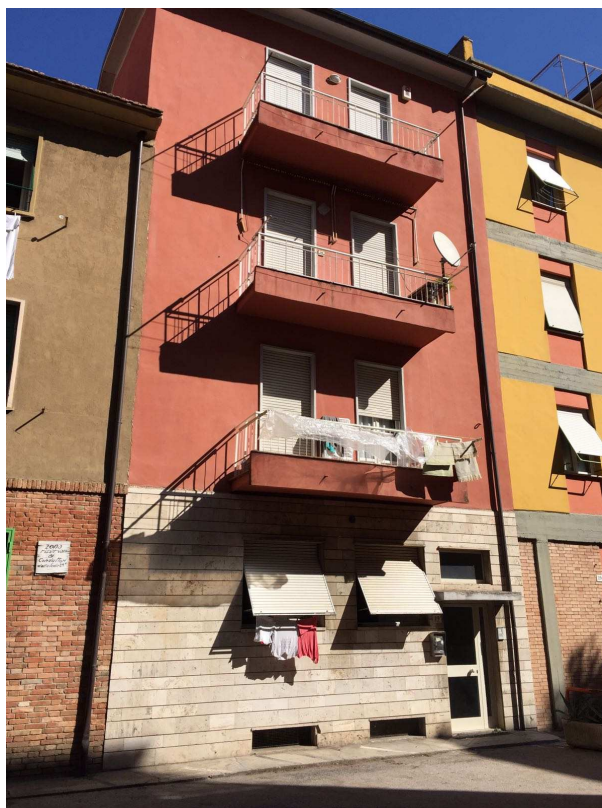
Facciata dell'edificio in linea; l'appartamento periziato si trova al primo piano
