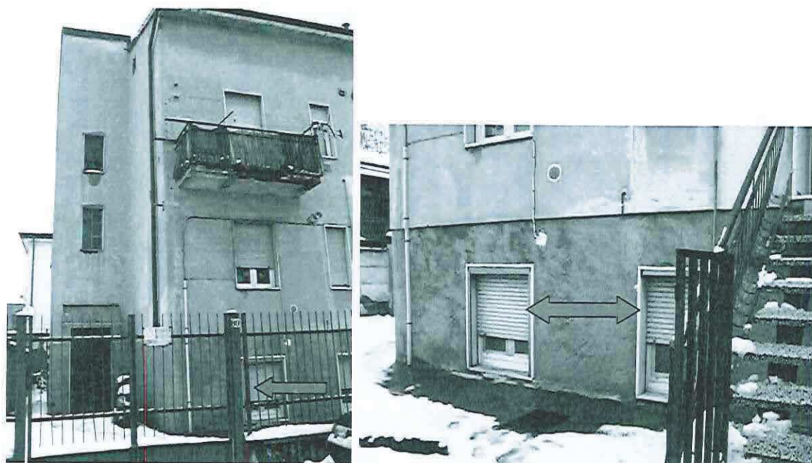
Foto n. 5-6 : fronte sud-ovest - finestra piano seminterrato particella 441 , sub. 707
