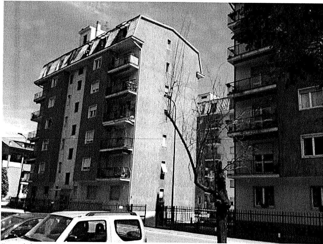
Vista del complesso immobiliare da Via Fiume – civico 28/B
