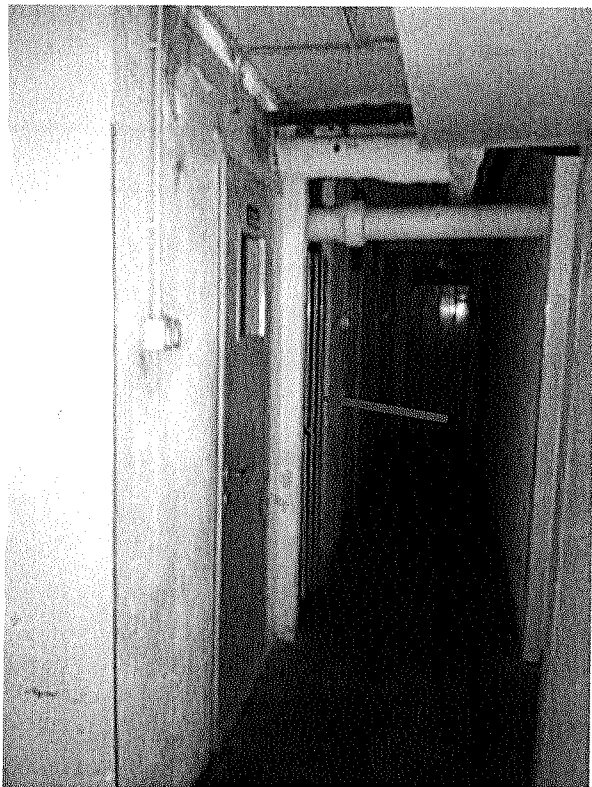
Vista del piano cantinato
