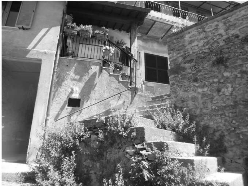
Vista 4: Via di comunicazione tra piano terreno e seminterrato
