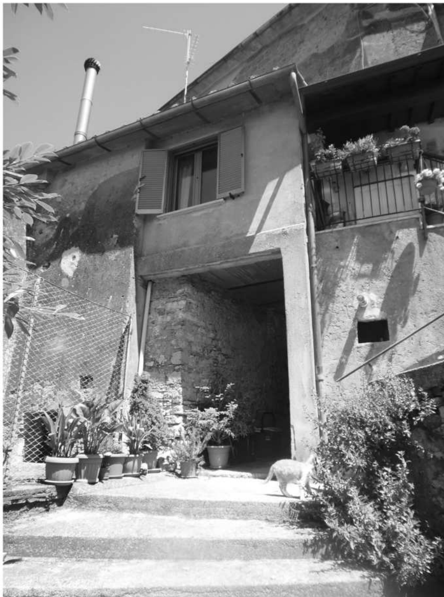
Vista 5: Accesso al locale cantina, Piano Seminterrato
