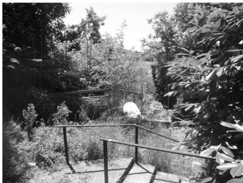
Vista 18 : Serbatoio GPL antistante il locale cantina
