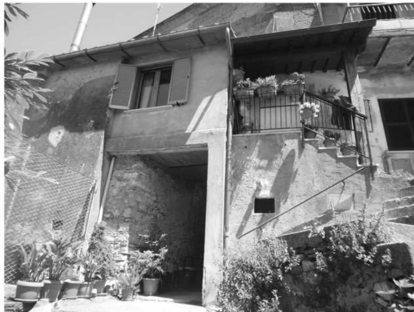
Vista 3: Accesso al locale cantina, Piano Seminterrato
