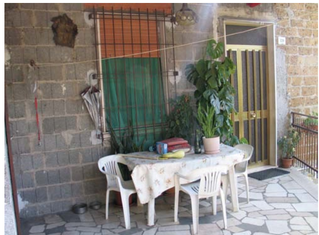
Foglio 98 particella 265 sub.1: portone d'ingresso
