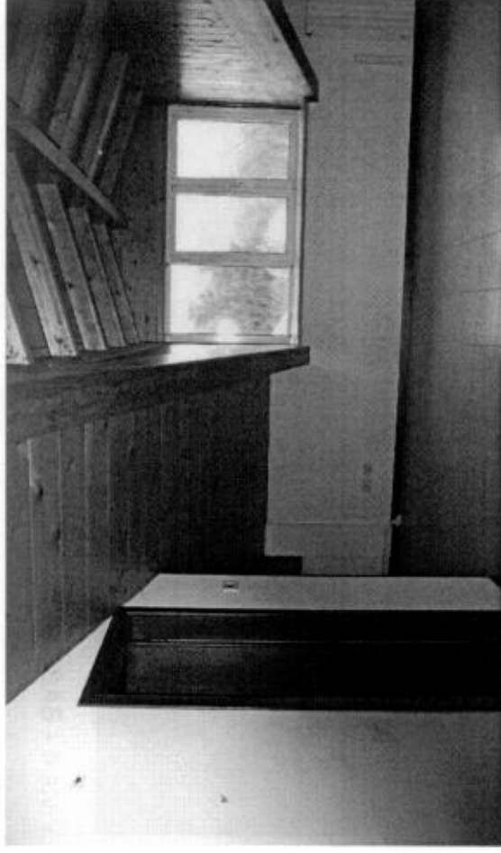
Vista 6 - part. SOTTOTETTO
